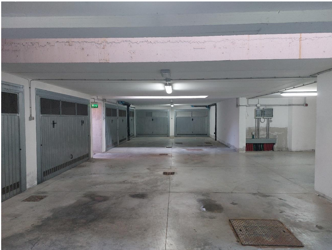
FOTO 3 – AREA COMUNE DI MANOVRA
