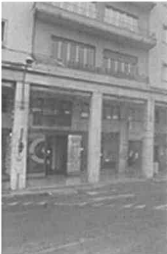
Foto 1: fronte su Corso Marengo
