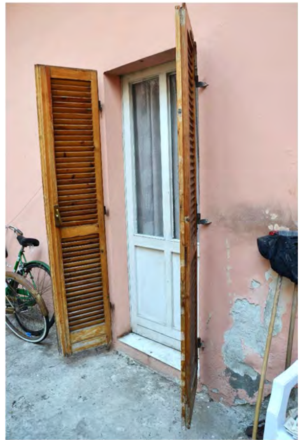
Vista fotografica porta-finestra verso cortile interno
