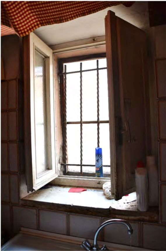
Vista fotografica finestra cucina verso cortile interno
