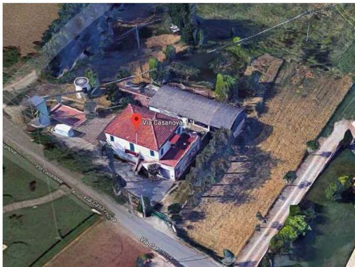
FOTO 1: vista aerea del complesso edilizio in oggetto per il solo piano terra
