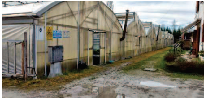
Particelle 714 - 709 – 249 - Serre su lato Nord
