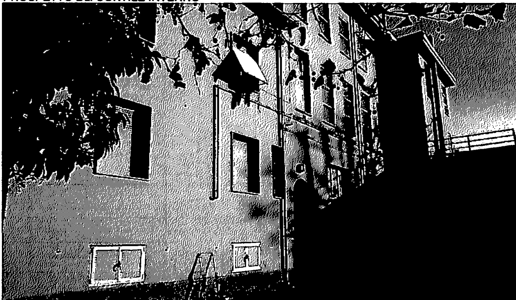
PROSPETTO Dal CORTILE INTERNO
