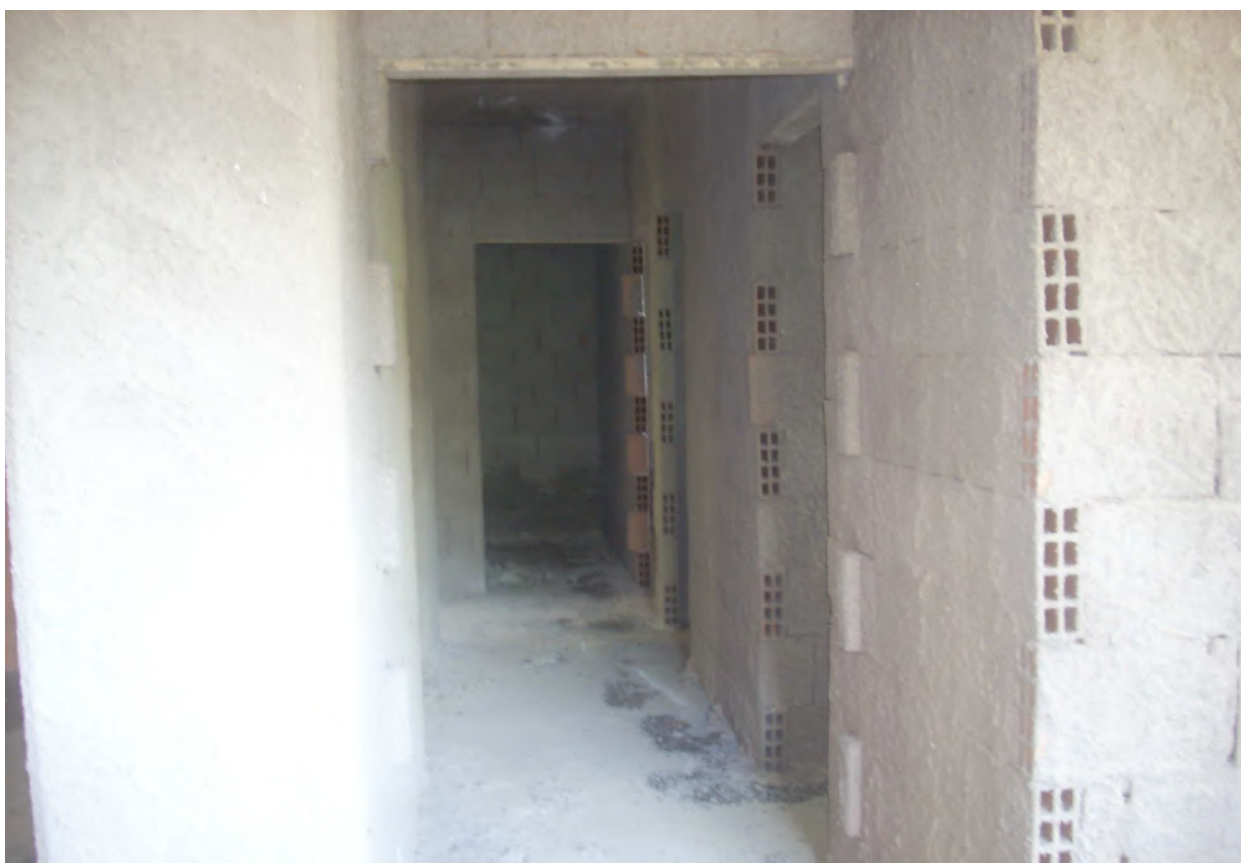
Foto n° 12: Particolare vista interna piano terra
