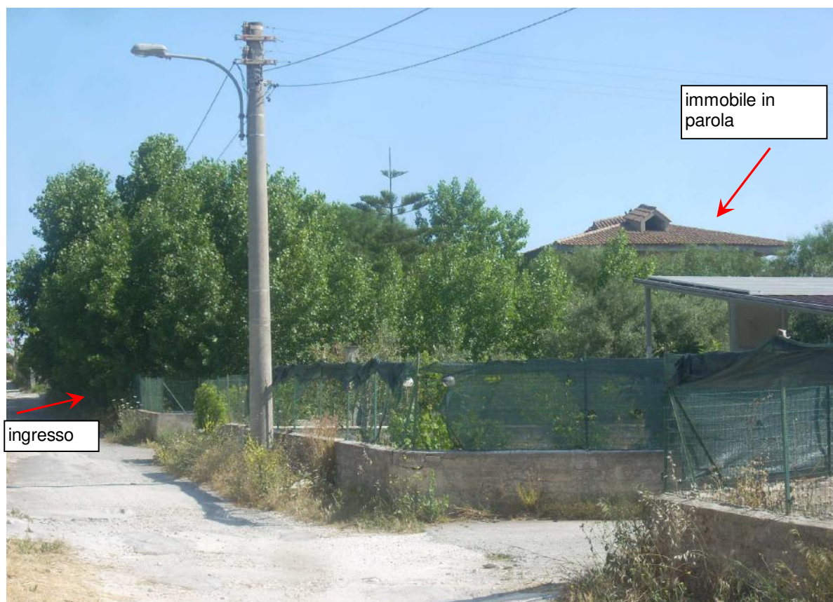
Foto n° 2: Vista opposta foto n. 1 via Francoforte
