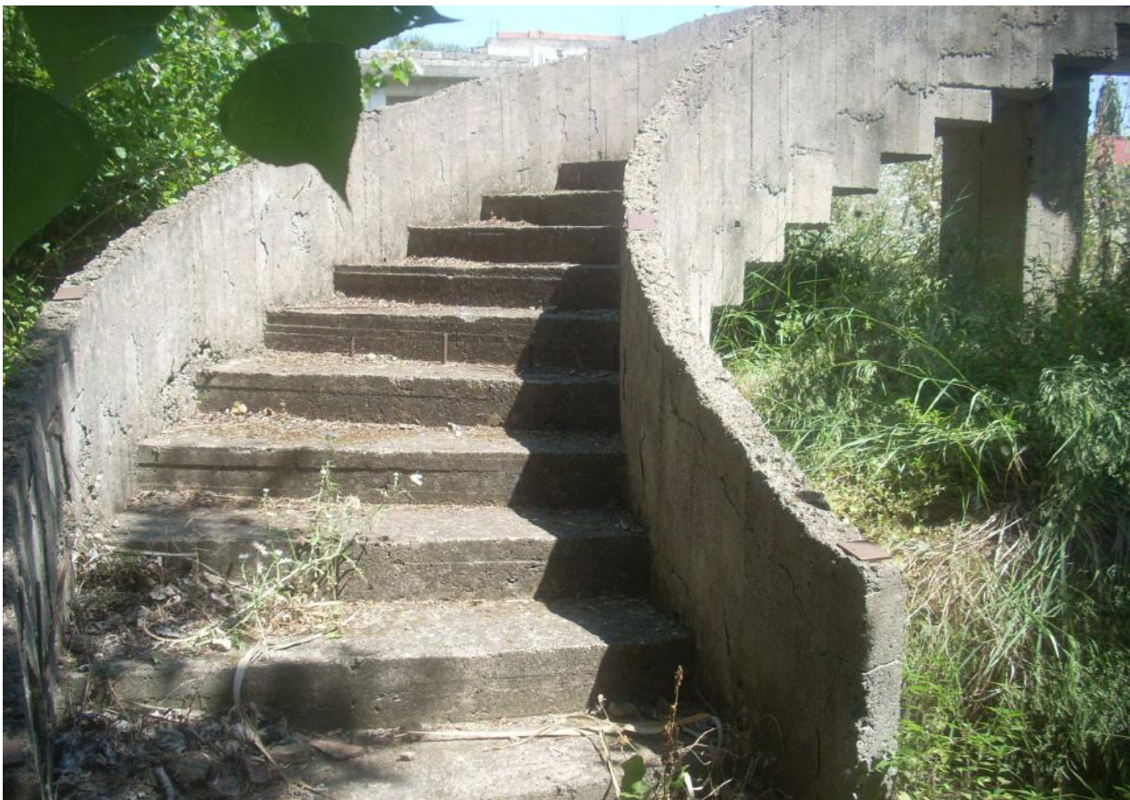
Foto n° 13: vista scala elicoidale per accesso al piano primo - tratto iniziale
