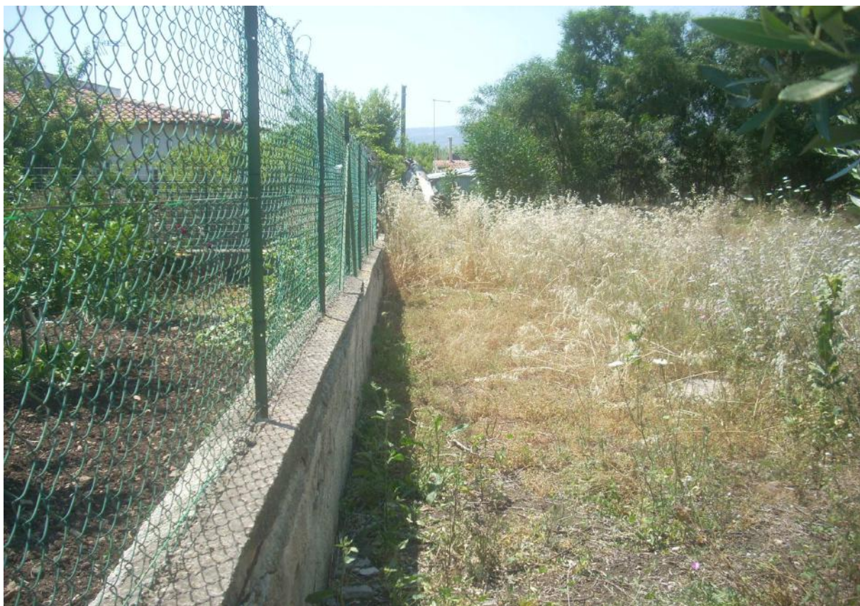
Foto n° 18: Vista muretto di recinzione lato Est
