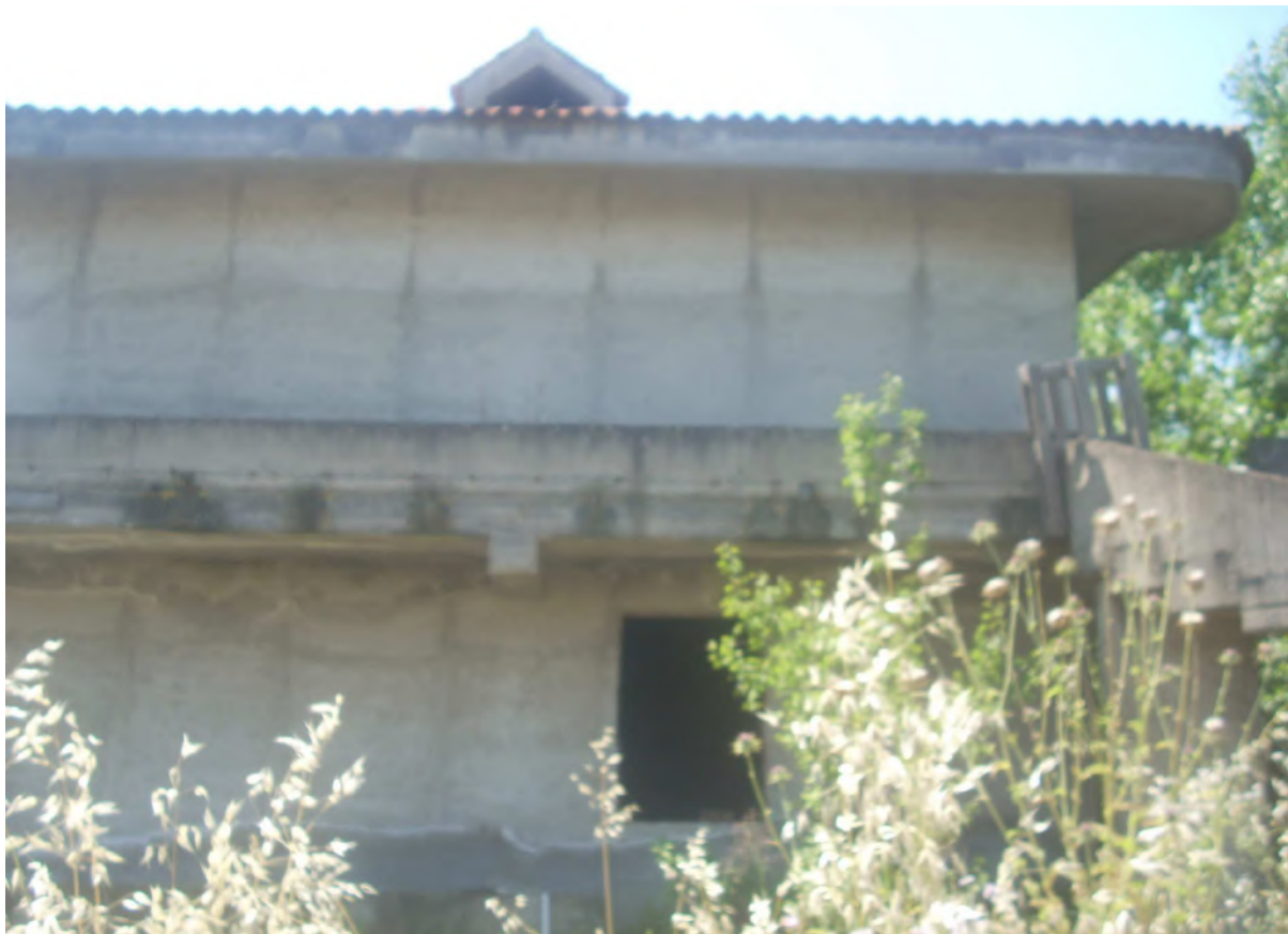
Foto n° 10: stralcio vista prospetto Sud
