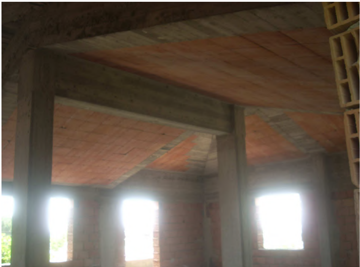
Foto n° 16: altra vista piano primo ed intradosso tetto di copertura.
