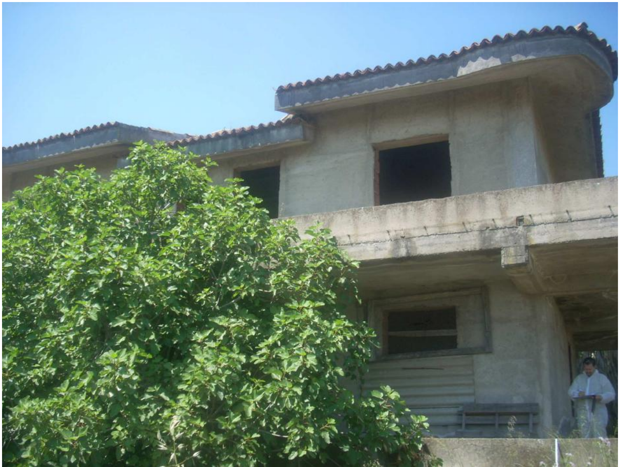
Foto n° 9: stralcio vista prospetto Est
