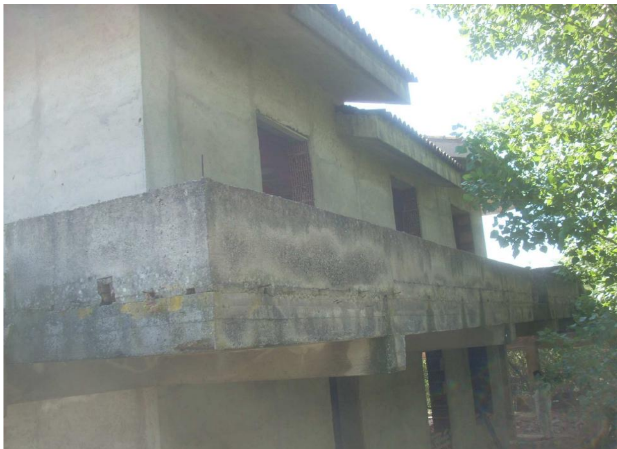
Foto n° 11: stralcio vista prospetto Ovest
