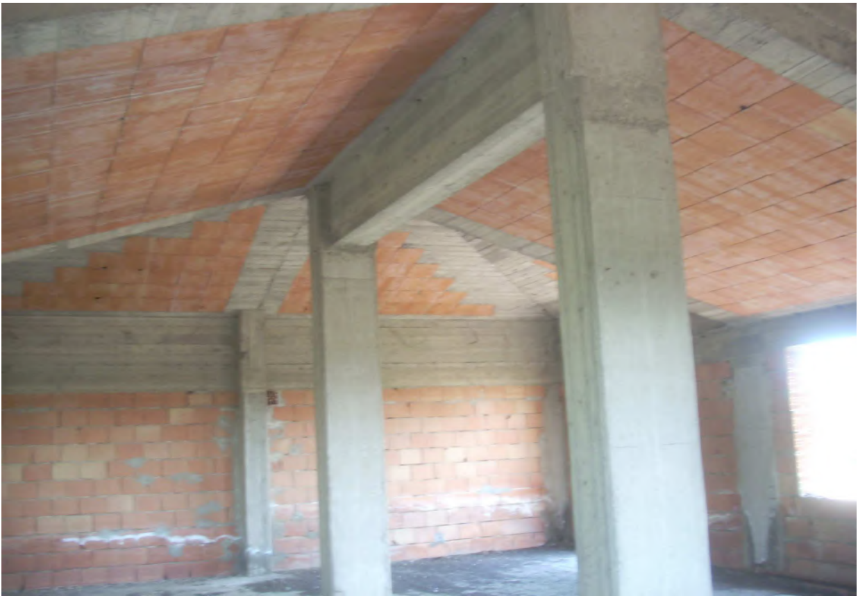
Foto n° 15 Vista piano primo ed intradosso tetto di copertura
