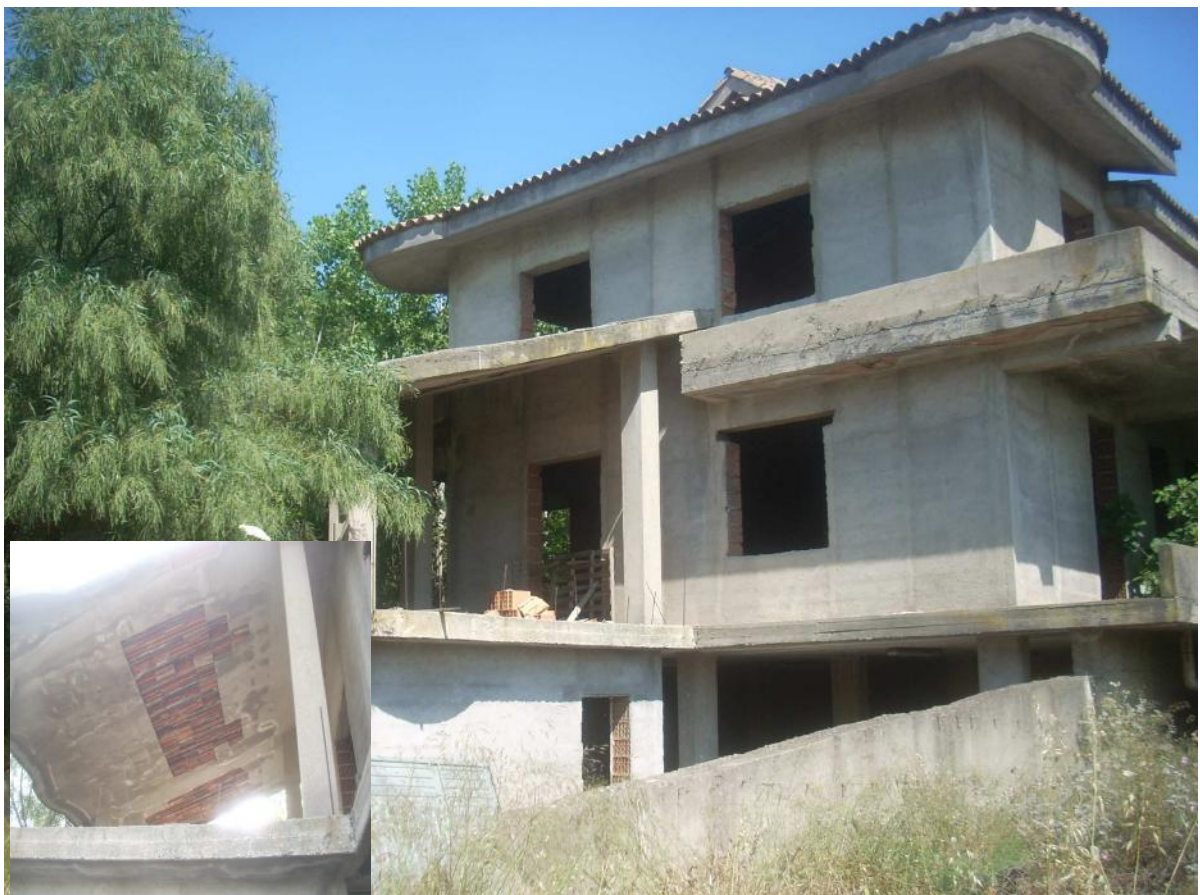
Foto n° 8: Vista prospetto Sud - particolare intradosso tetto veranda.
