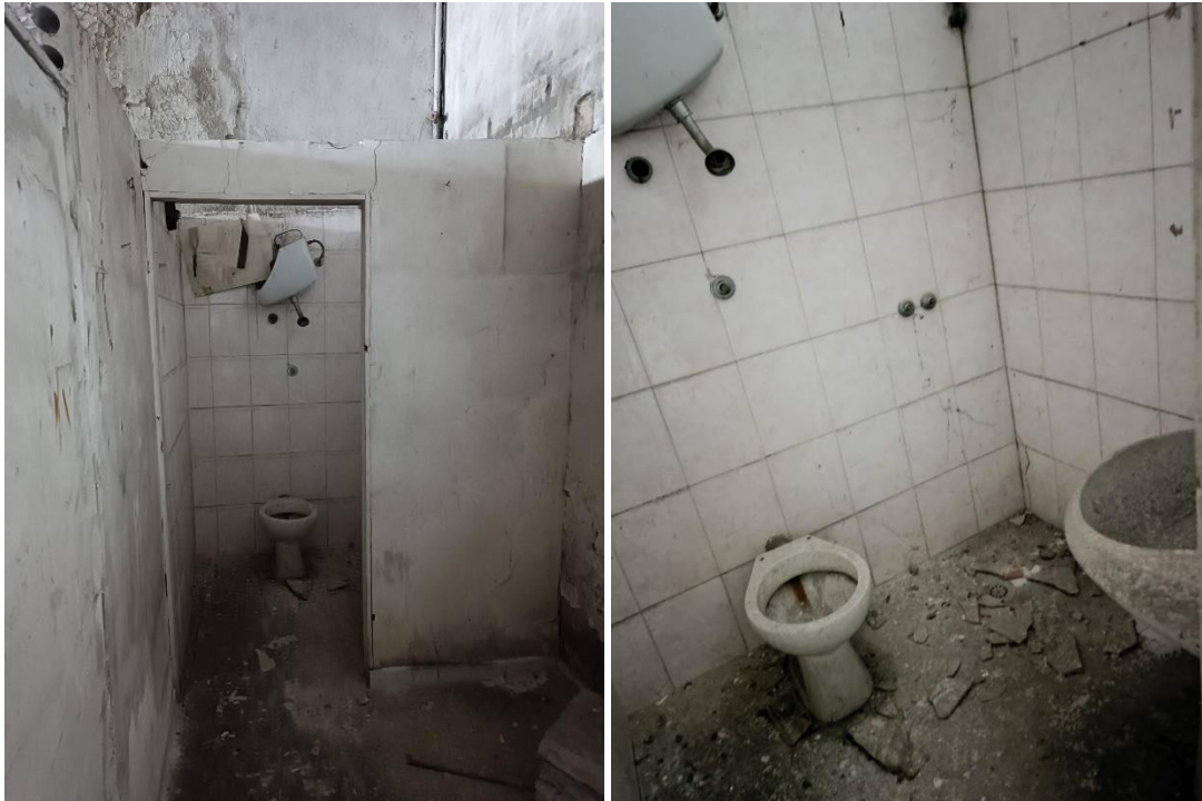
Foto 9 – Foto 10. Interno locale bagno
