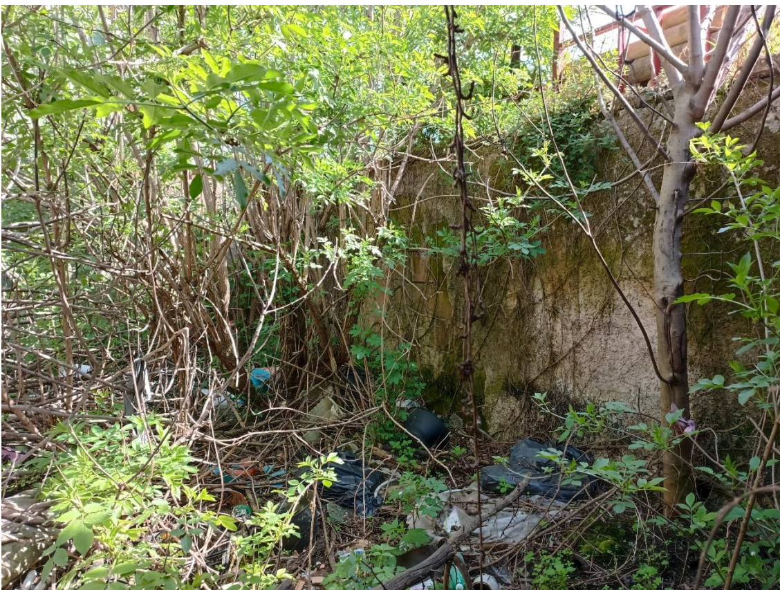
Foto 7. Giardino esterno piano terra, comune ai tre lotti
