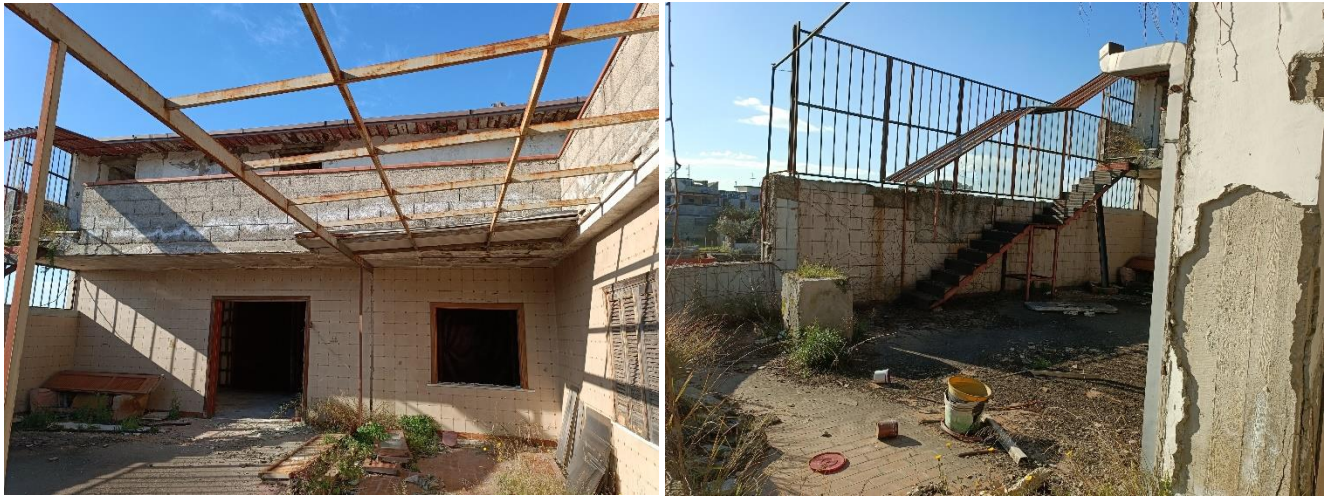
Foto 35: Vista a quota terrazzo immobile piano primo verso l'immobile posto sul lastrico solare
