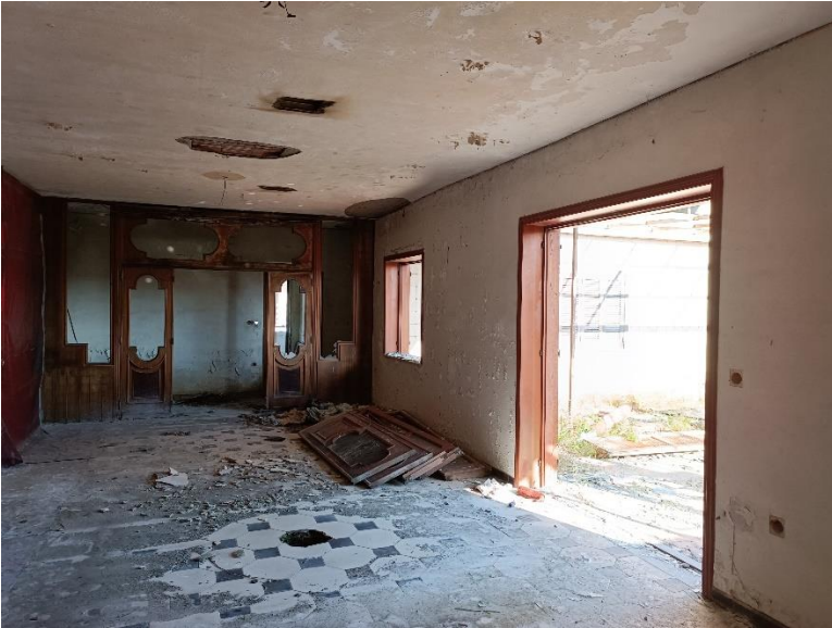
Foto 9: vista interna appartamento
