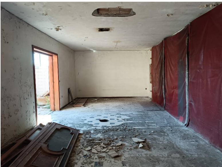
Foto 10: vista interna appartamento
