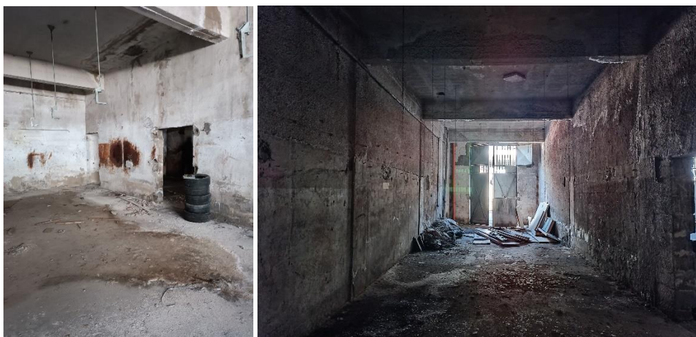
Foto 13 – Vano aperto tra il sub 3 ed il sub 2
