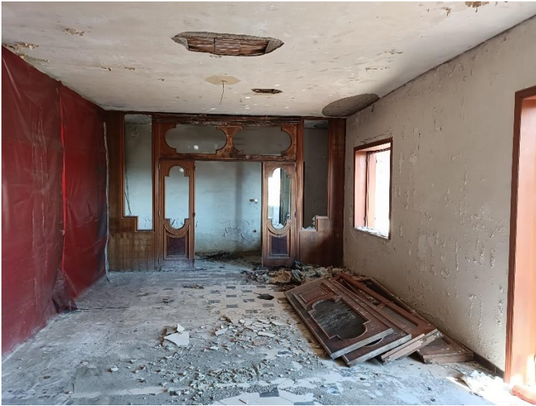
Foto 8: vista interna appartamento
