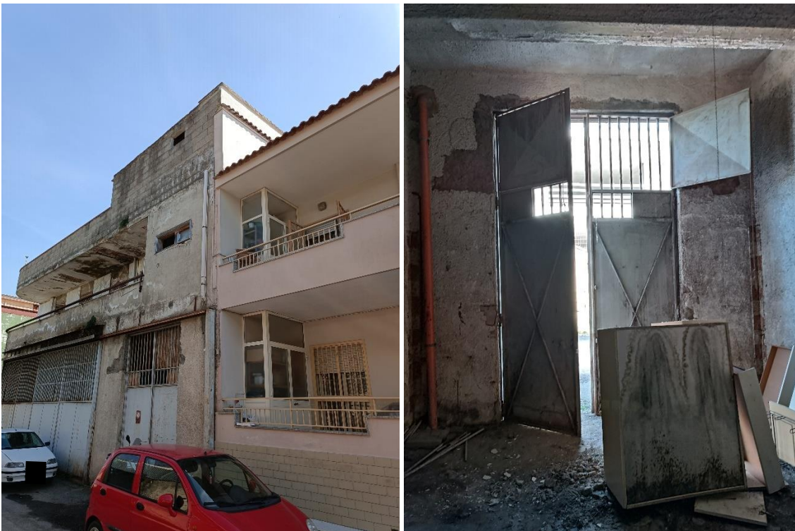
Foto 11: Ingresso da Via Torino (unico ingresso) - 12. Interno locale
