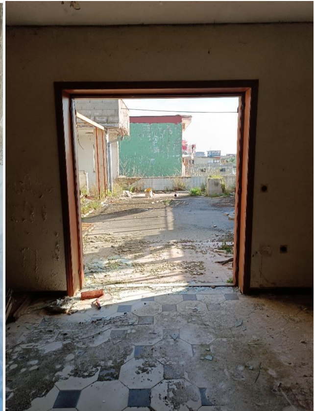
Foto 21 - Balcone su via Torino - Foto 22: uscita sul terrazzo piano primo
