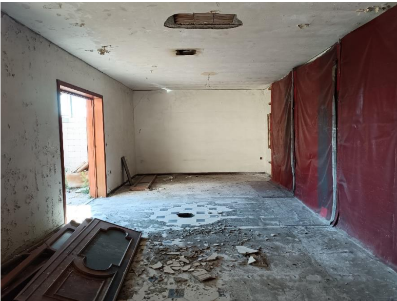
Foto 10: vista interna appartamento
