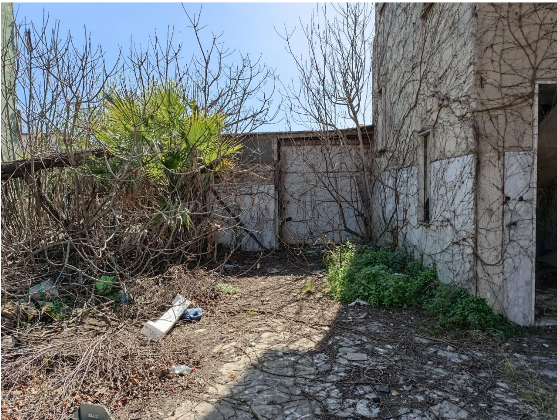
Foto 5. Giardino esterno piano terra, comune ai tre lotti
