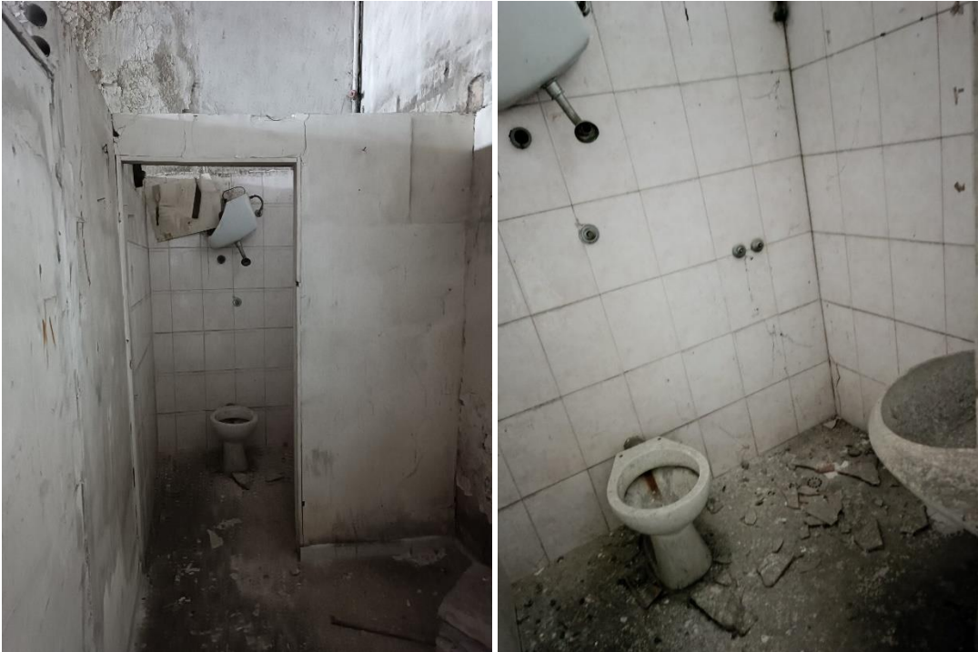
Foto 9 – Foto 10. Interno locale bagno
