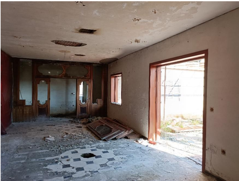
Foto 9: vista interna appartamento
