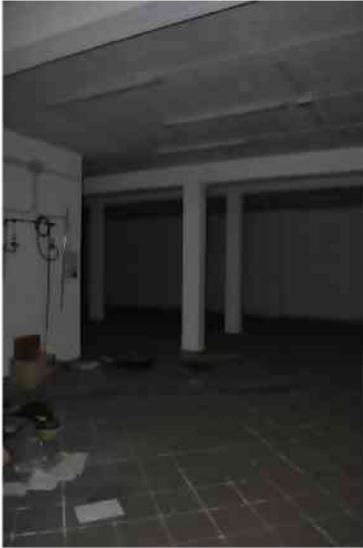
Vista interna sub 29
