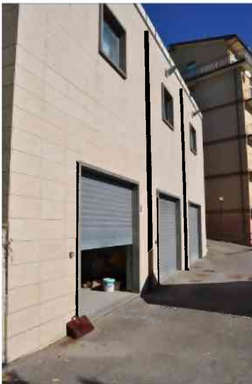
Vista ingresso sub 27
