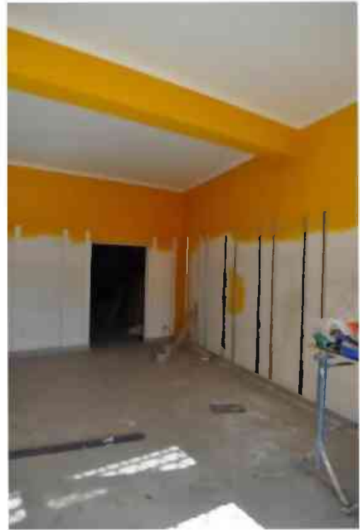
Vista interna sub 28 e passaggio al sub 29
