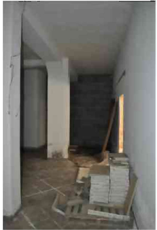
Vista interna sub 30
