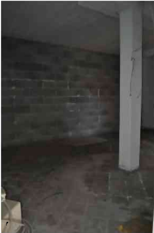
Vista interna sub 30
