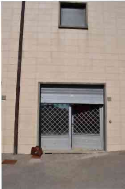
Vista dell'ingresso dell'unità sub 28
