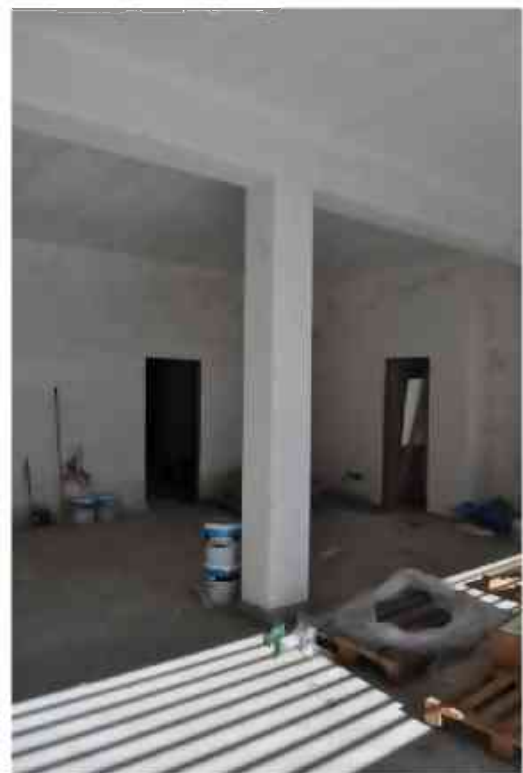
vista interna sub 27
