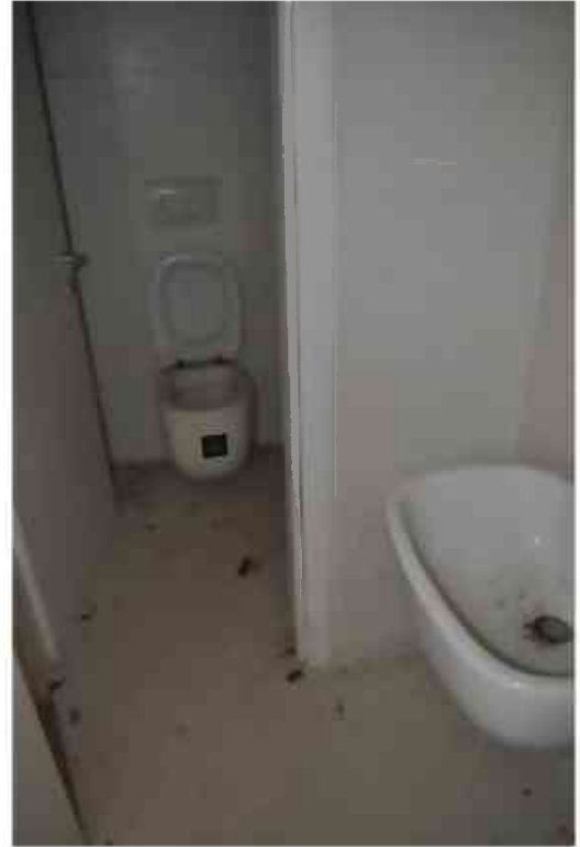
Servizio igienico sub 28
