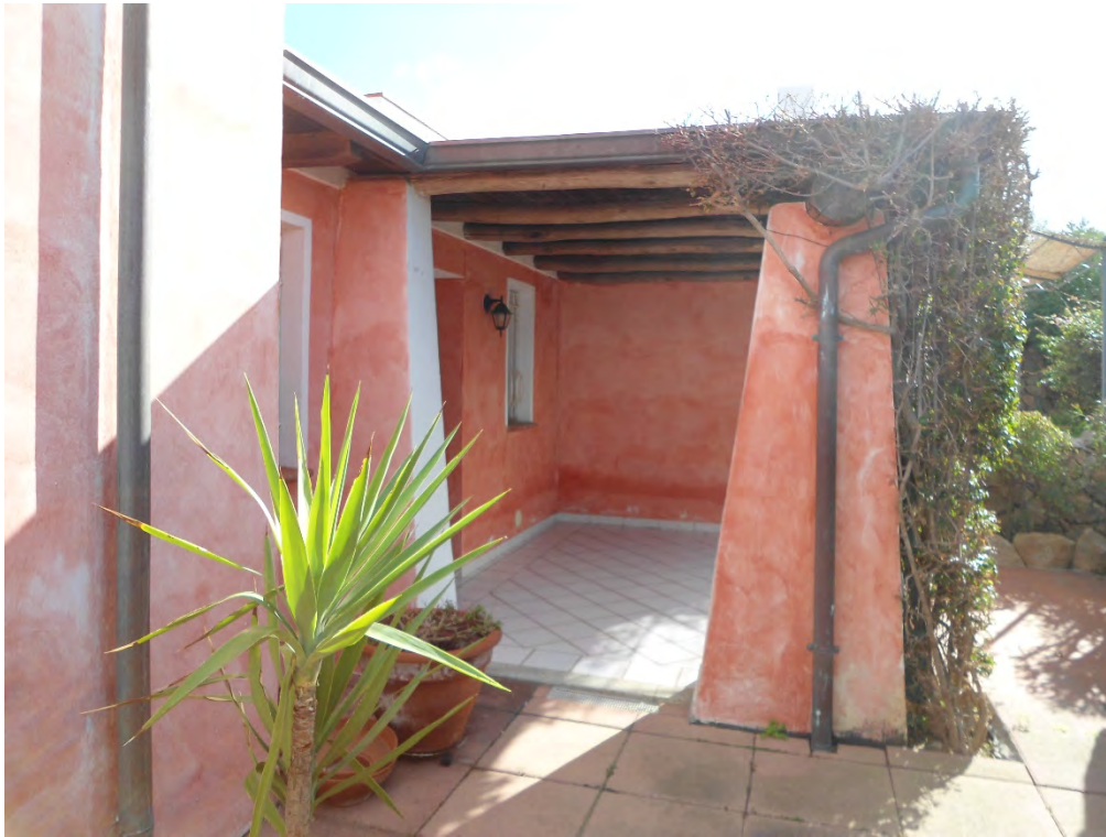
Foto n.5 – Veranda sul fronte d'ingresso (S-O)
