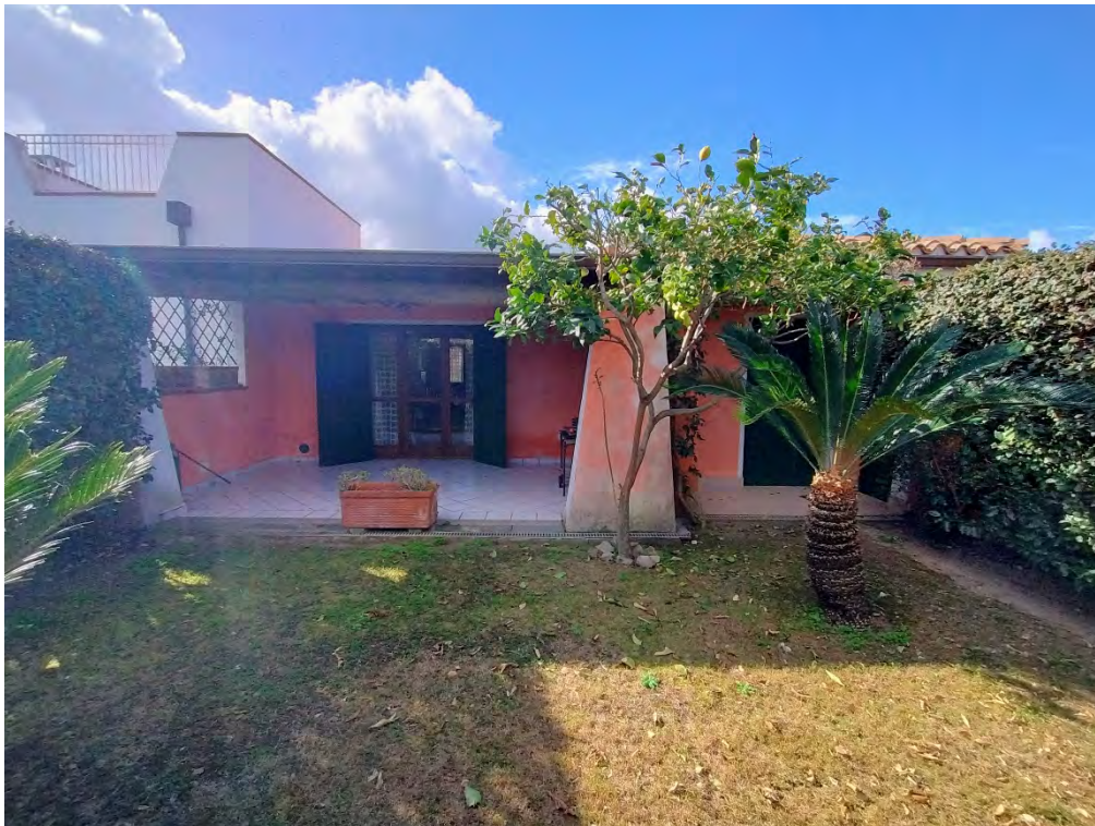
Foto n.10 – Panoramica del fronte prospiciente il giardino interno (N-E)
