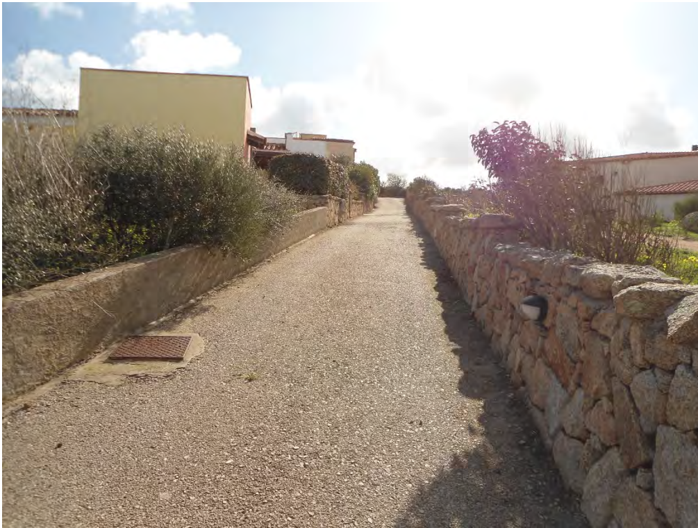
Foto n.1 – Strada carrabile di lottizzazione in arrivo dal parcheggio/posto auto
