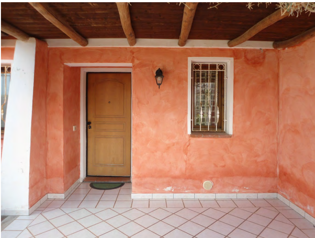
Foto n.4 – Veranda sul fronte d'ingresso con portone d'ingresso (S-O)
