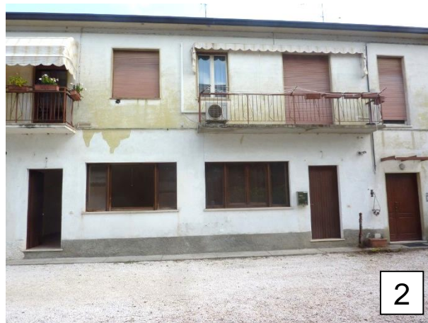
Particolare facciata sud
