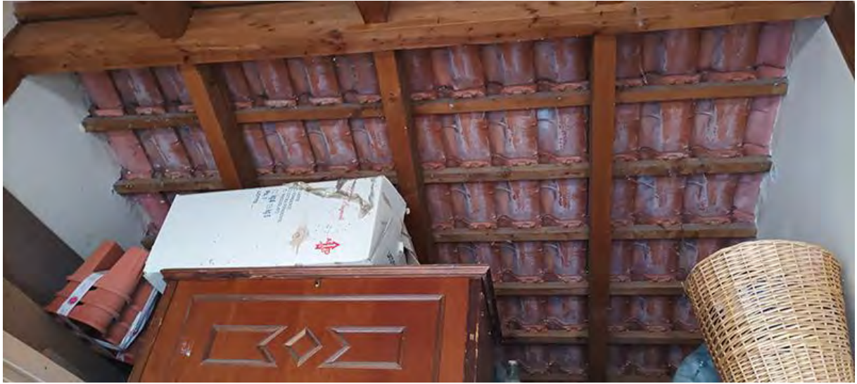
COPERTURA A VISTA DEL BOX AUTO 3 – SUB 45
