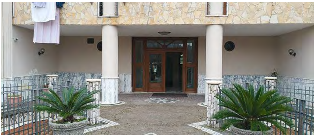
ACCESSO ALL'ANDRONE DELL'EDIFICIO
