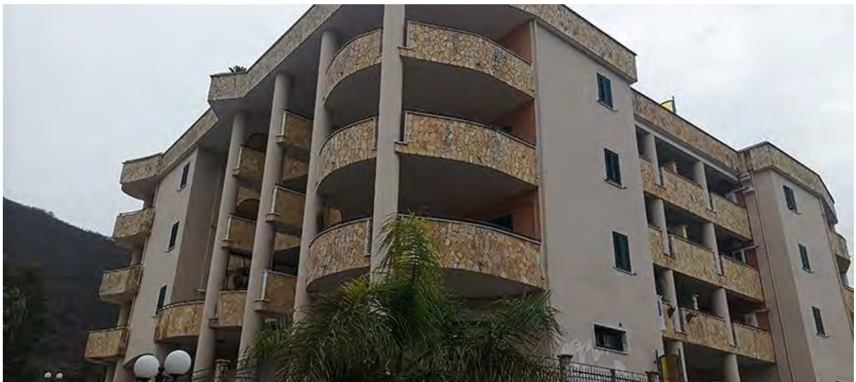
VISTA DA AREA CONDOMINIALE AD EST (TERRAZZO NORD-EST)
