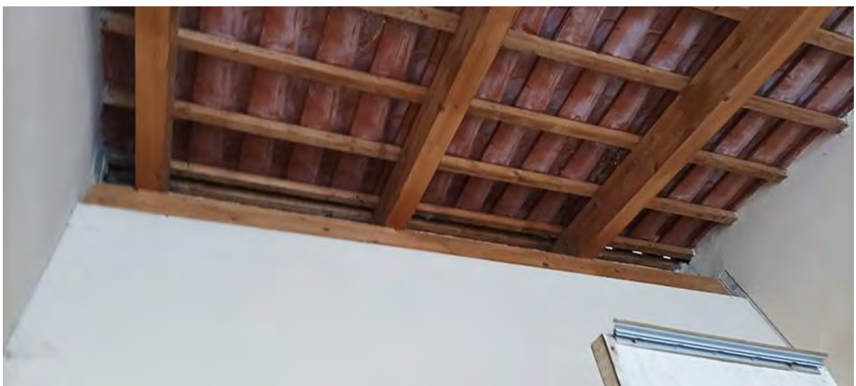
COPERTURA A VISTA DEL BOX AUTO 1 – SUB 35
