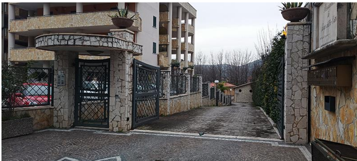
ACCESSI AL COMPLESSO IMMOBILIARE DALLA STRADA
