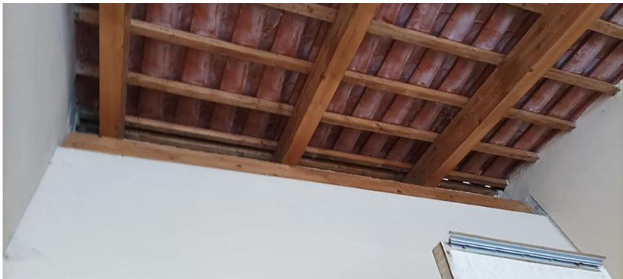
COPERTURA A VISTA DEL BOX AUTO 1 – SUB 35
