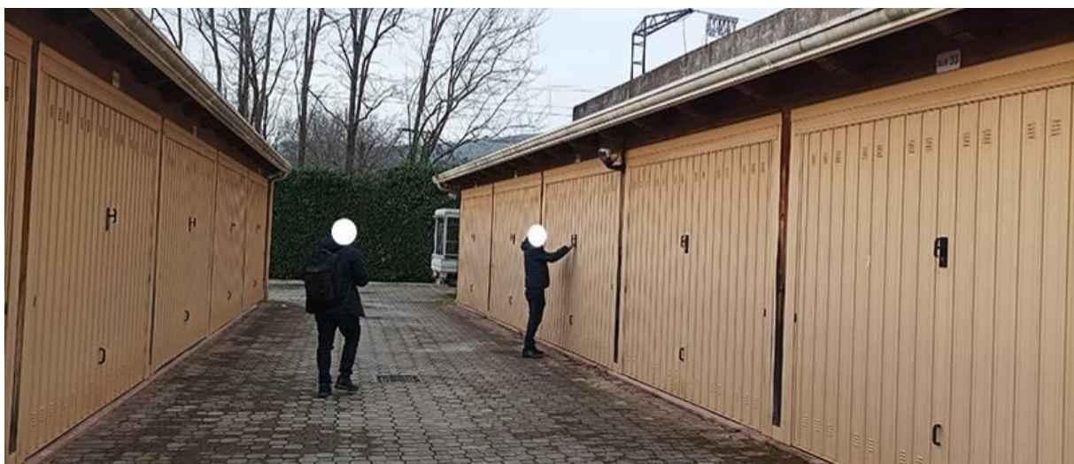
PROSPETTI DEI BOX AUTO SU AREA DI MANOVRA BOX 1 E 2 A DESTRA E BOX 3 A SINISTRA
