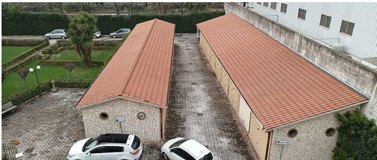
VISTA DAL TERRAZZO 2 DEI FABBRICATI DESTINATI A BOX AUTO
