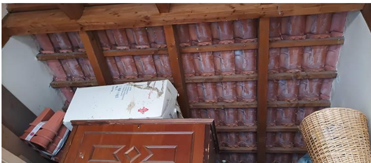
COPERTURA A VISTA DEL BOX AUTO 3 – SUB 45
