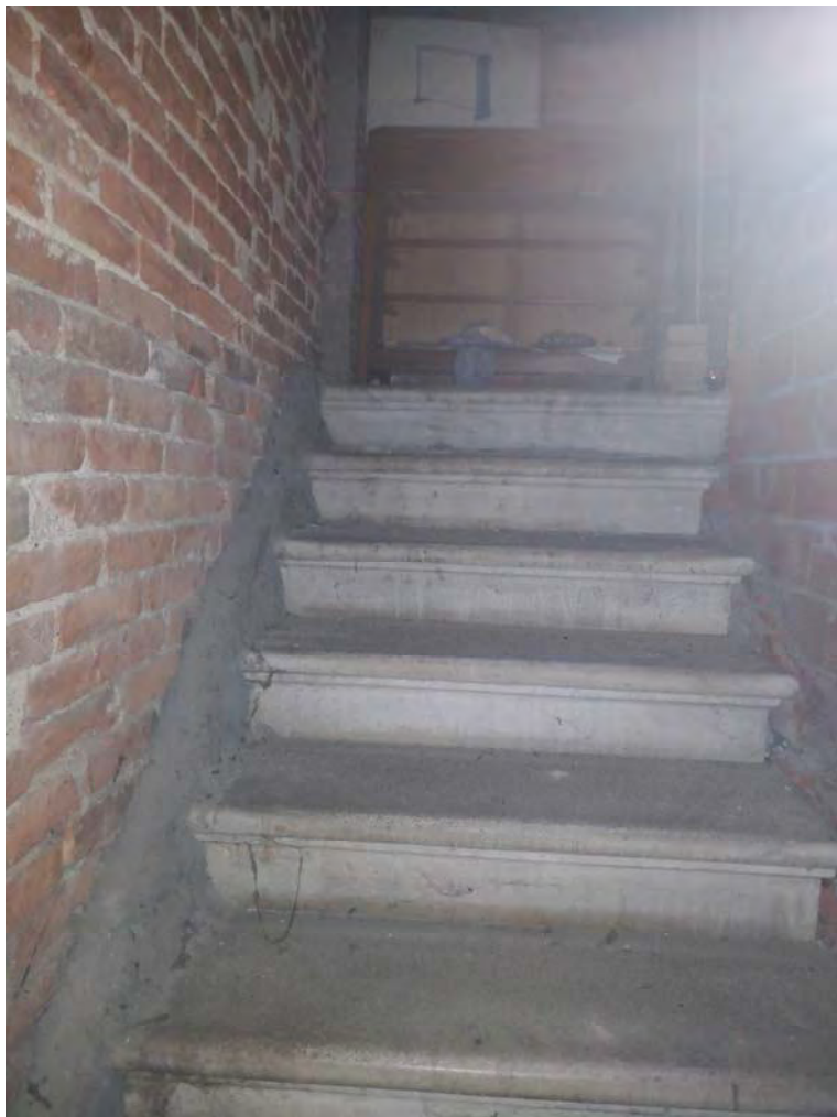
FOTO 64 - scala accesso piano soffitta
