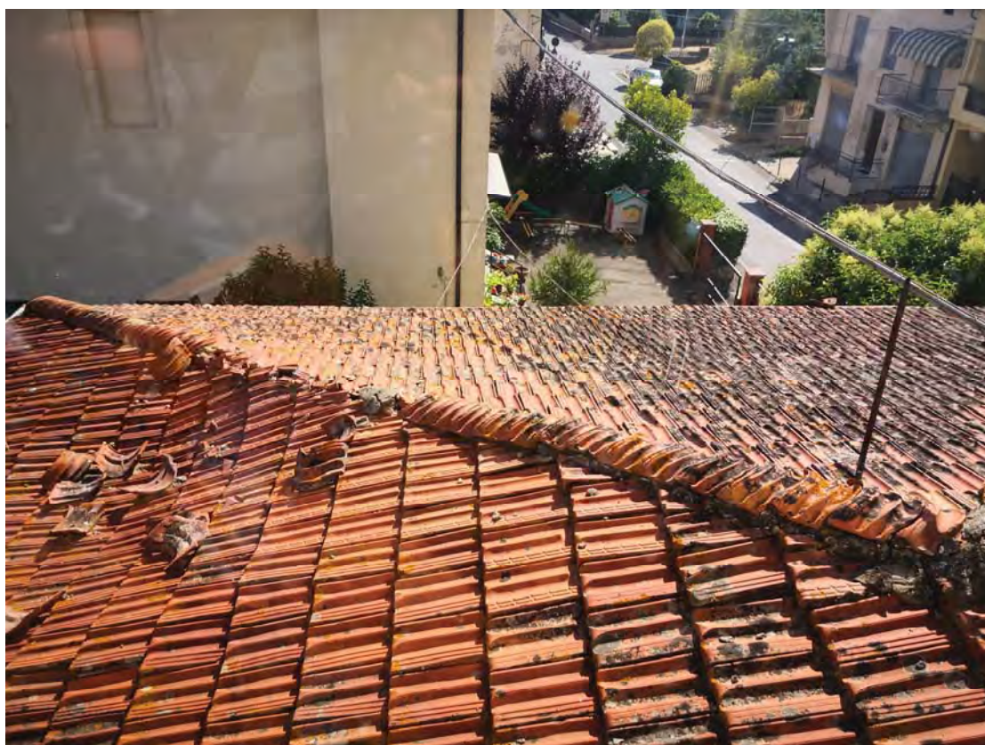
FOTO 68 e 69 - Viste esterne copertura
