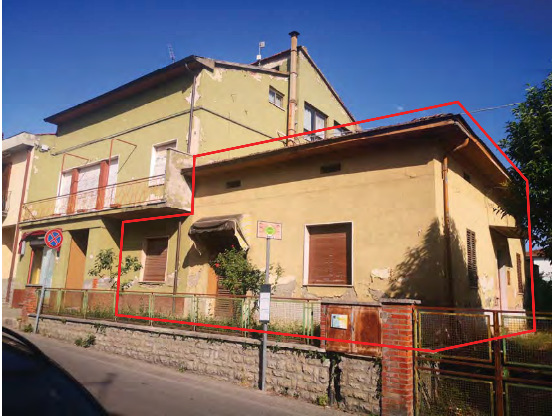
FOTO 50 - Vista lotto da via Rigutino Sud
