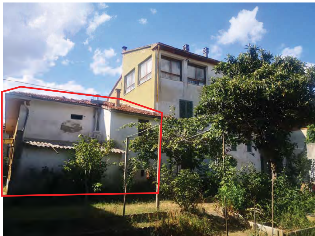
FOTO 74 - Vista da resede a comune con lotto 1
