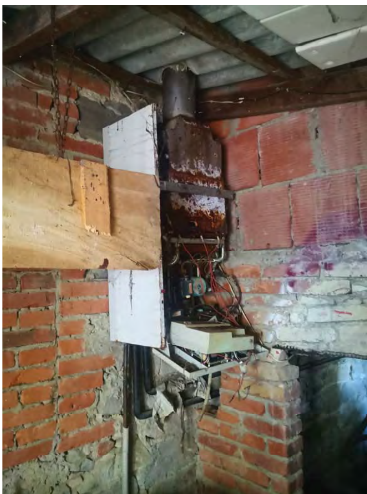
FOTO 71 - vista interna garage
