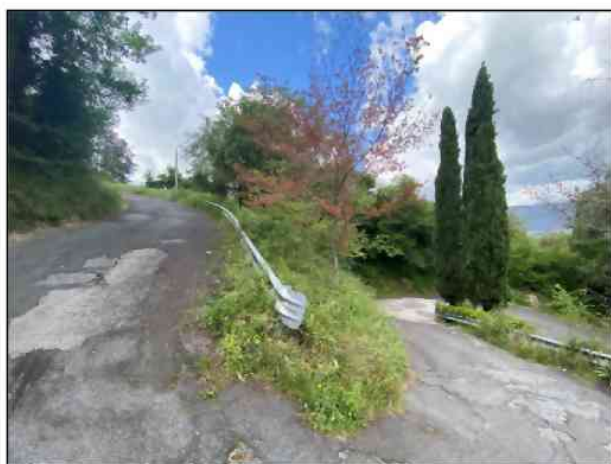
P. 8 - Vista da Via Aniene sotto
