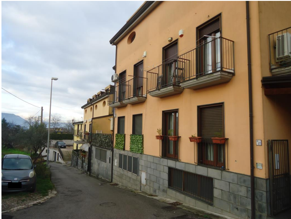
Complesso in Mercato San Severino via Monticelli di Sopra
