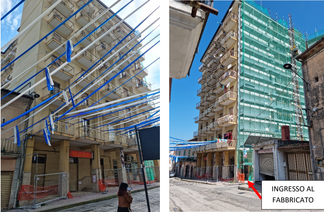
Veduta del fabbricato da Via G. Matteotti, in evidenza il palazzo di 8 piani che si staglia isolato rispetto a caseggiati in muratura portante di 1/2 livelli del circondario. Come si vede dalla foto, sono in atto i lavori Superbonus 110%
