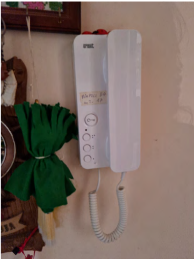
Foto 18 – Nuovo impianto citofonico
