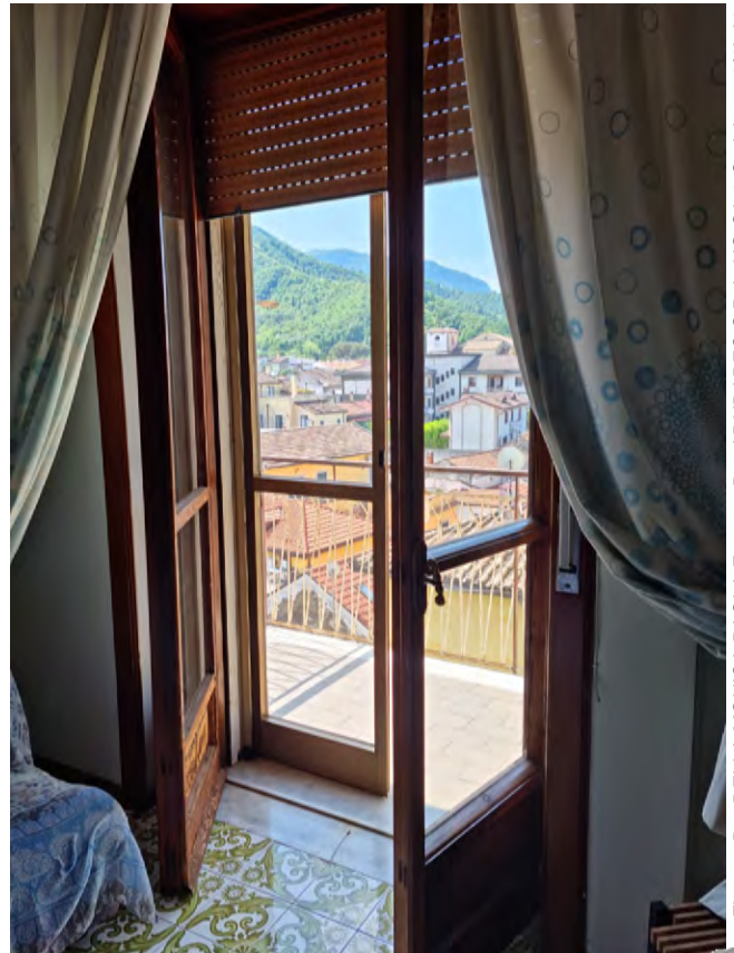
Foto 15 – Particolare infissi esterni
