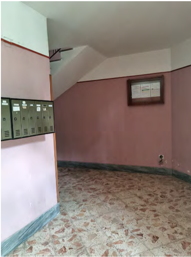
Foto 1 – Ingresso al piano terra
