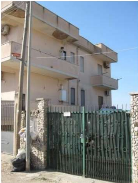
Figura 7 facciata nord del fabbricato a cui appartengono gli immobili pignorati
