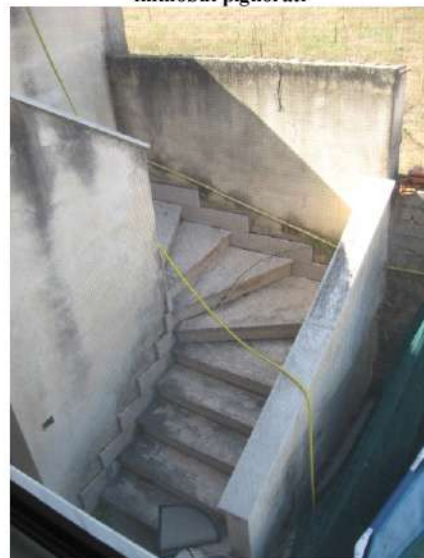
Figura 10 rampa di scale esterna per accesso al LOTTO N.4
