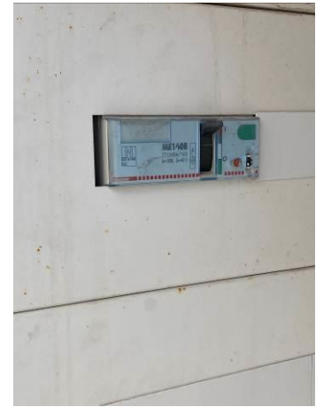
Interruttore magnetotermico
