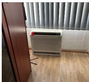
Unità ventilante interna
