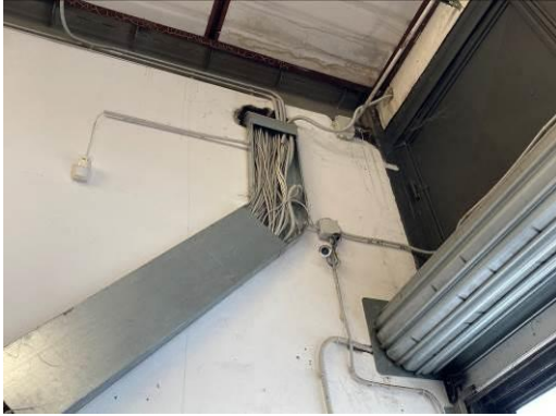
Partenza impianto elettrico
