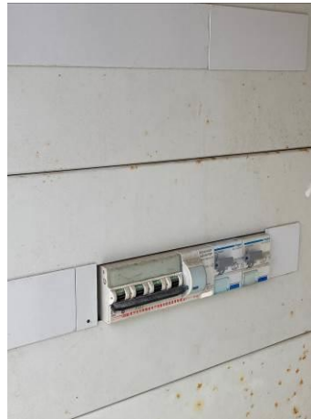
Differenziale magnetotermico + 2 diff. puri
