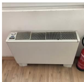
Unità ventilante interna
