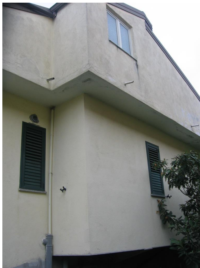
Prospetto Sud del fabbricato
