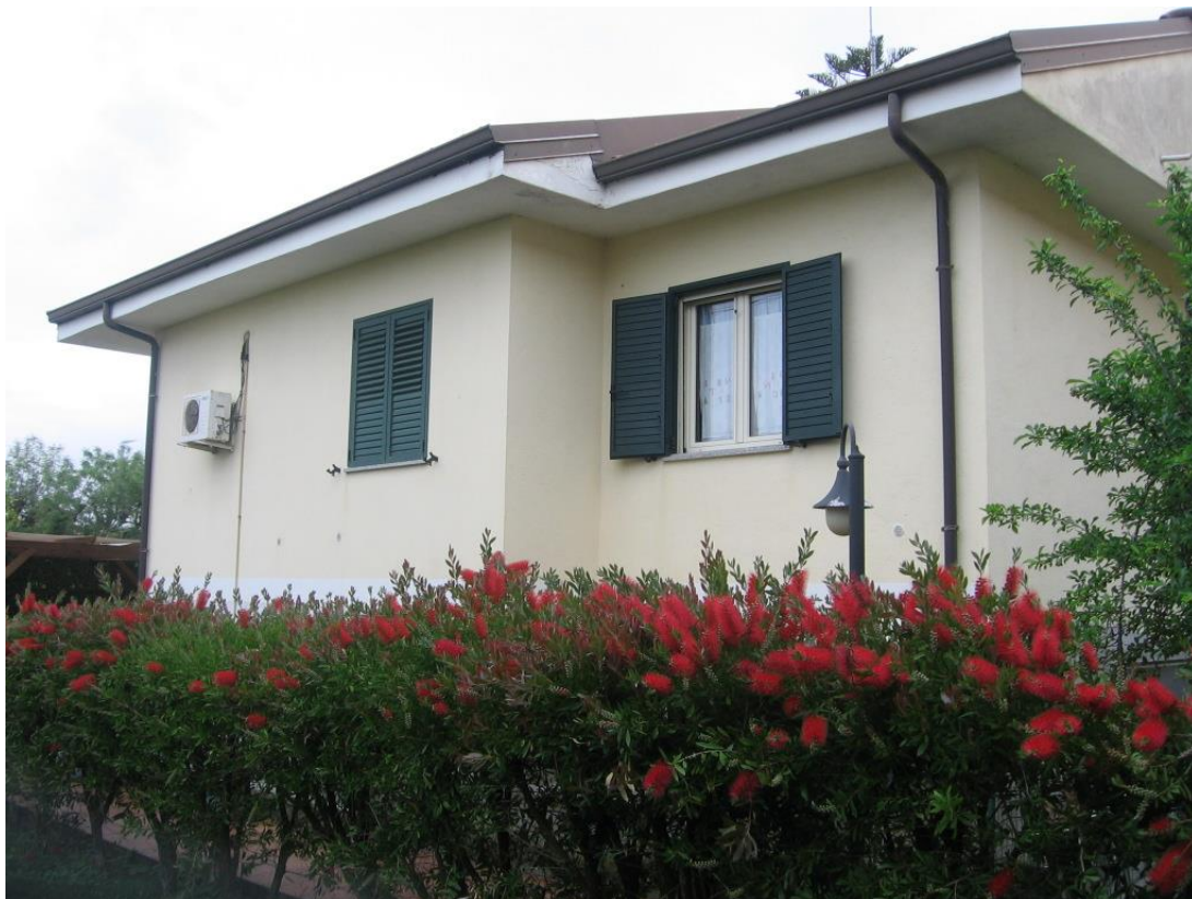
Prospetto Ovest del fabbricato
