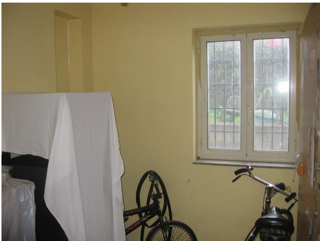
Deposito piano seminterrato
