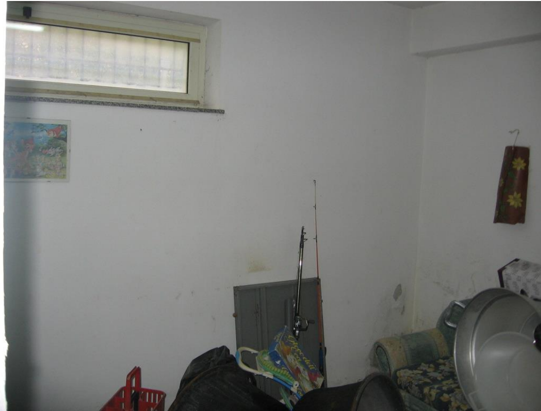
Deposito piano seminterrato
