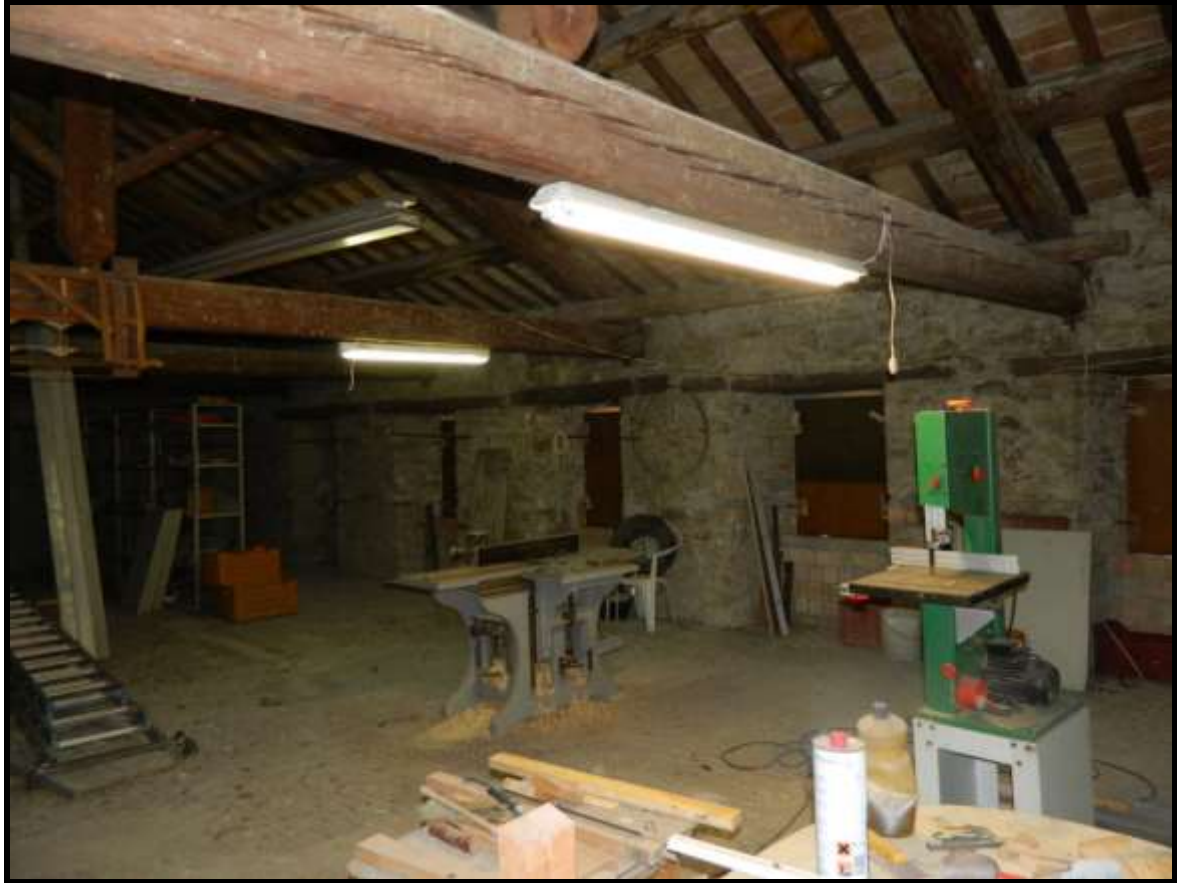
Foto 13 – Vista magazzino Piano Primo (Sottotetto)
