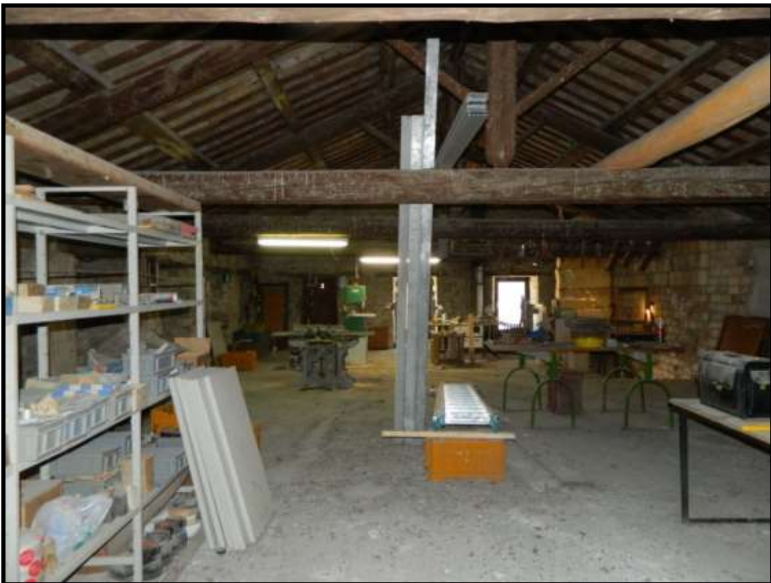
Foto 12 – Vista magazzino Piano Primo (Sottotetto)
