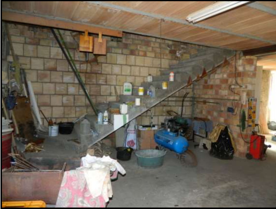
Foto 11 – Vista magazzino Piano Terra
