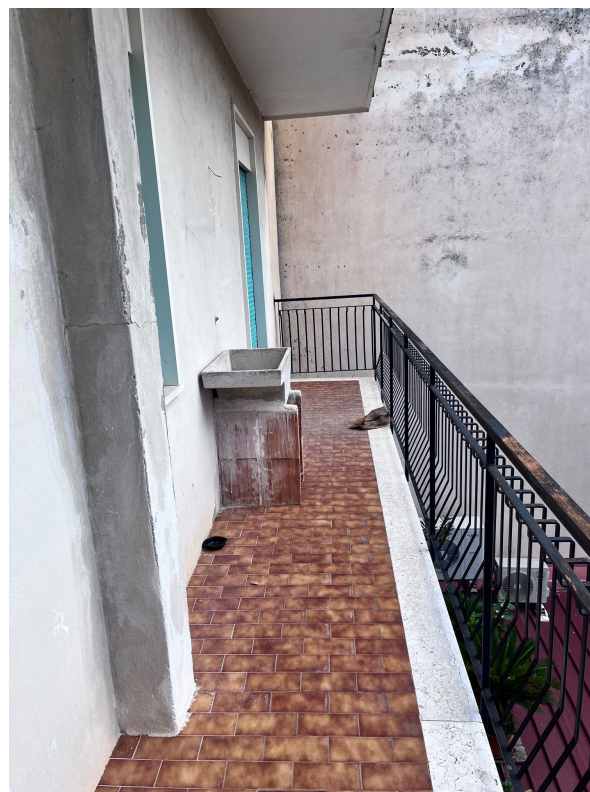
Prospetto cortile - balcone
