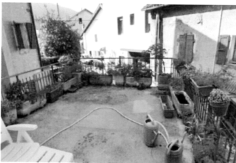
Figura 2 - LOTTO 01 – Lastrico solare - rilievo fotografico della porzione di fabbricato
