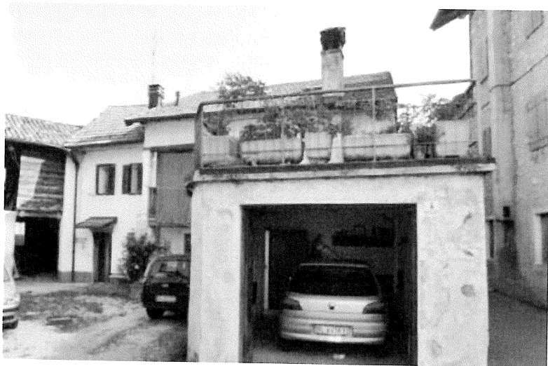
Figura 2 - LOTTO 01 – Garage - rilievo fotografico della porzione di fabbricato
