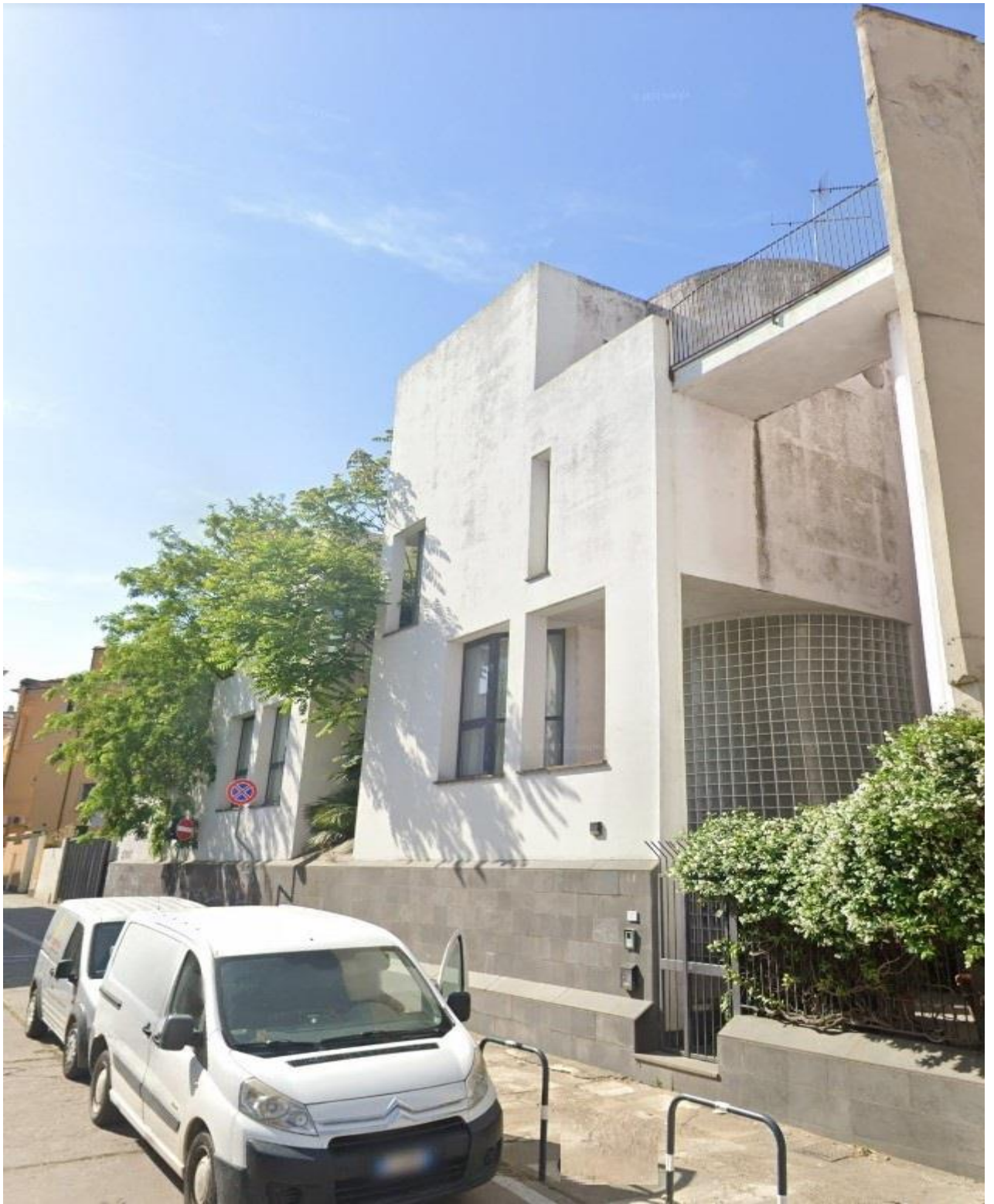
3) Vista 3 prospetto Via Giacomo Pala
