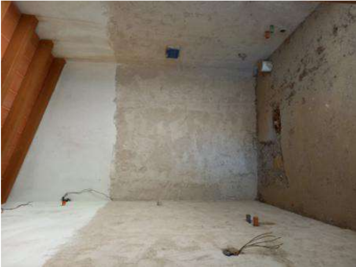
Foto 15 - locale con attacchi wc piano primo
