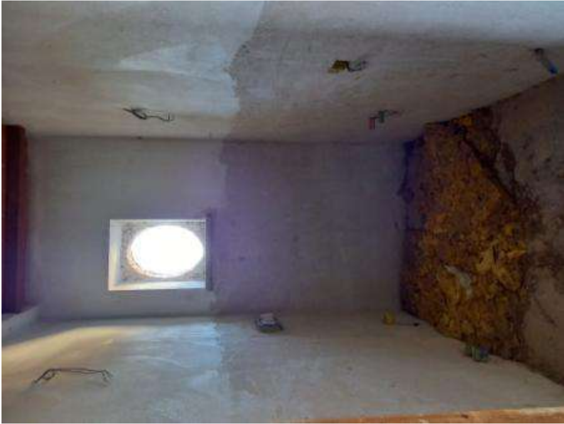
Foto 7 – locale con attacchi wc piano terreno
