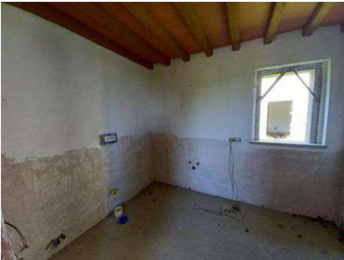
Foto 11 – locale con attacchi wc piano primo
