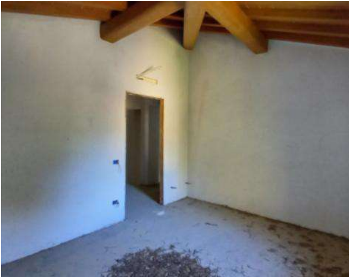
Foto 20 – locale piano primo
