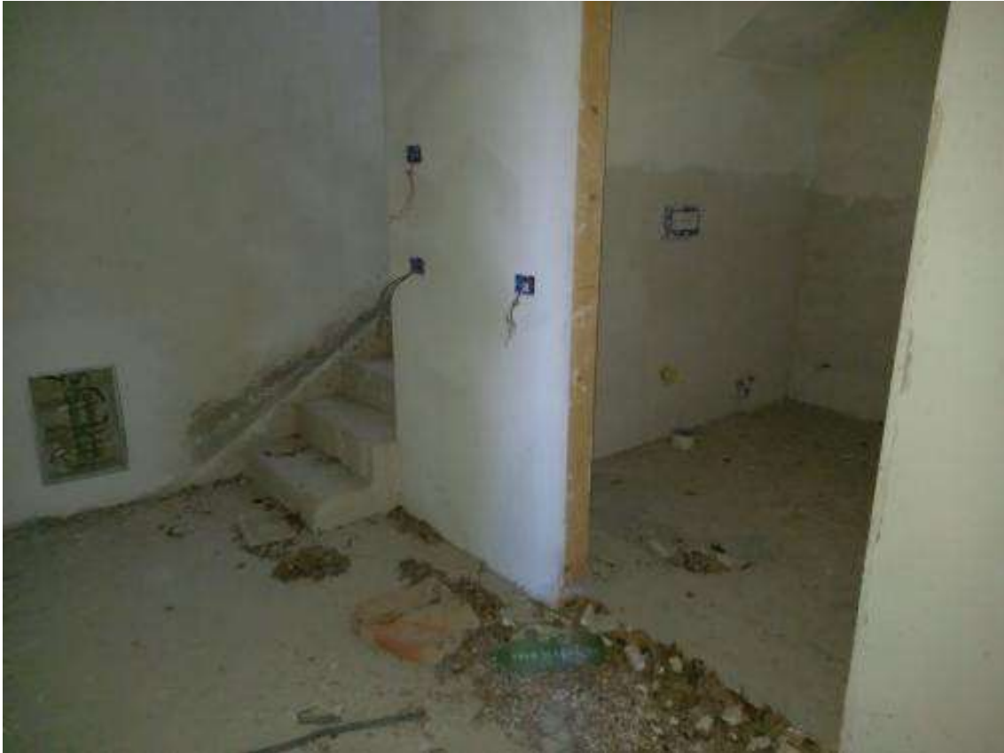
Foto 5 – locale con attacchi wc piano seminterrato
