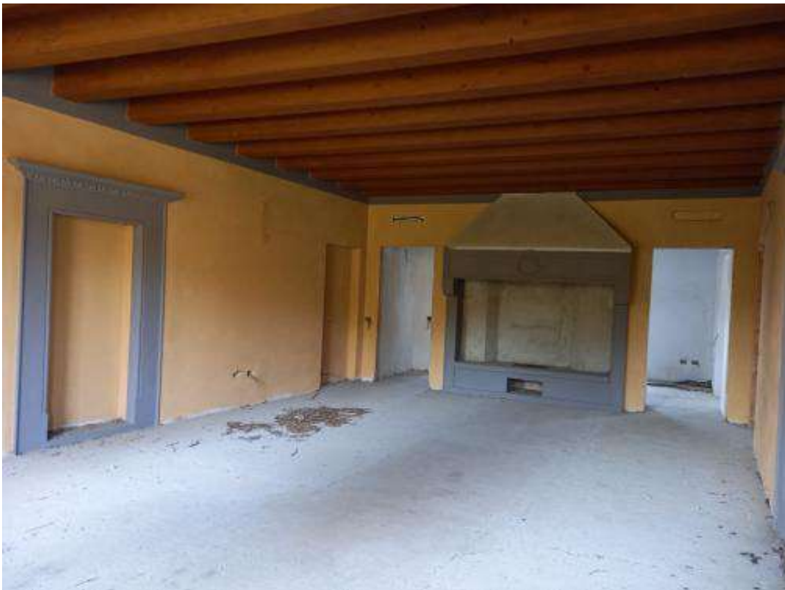
Foto 6- accesso principale piano terreno
