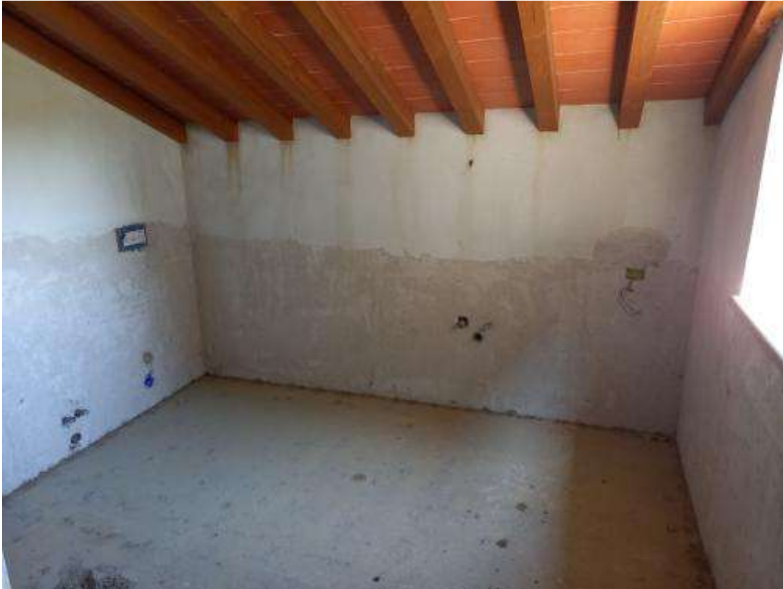
Foto17 – locale con attacchi wc piano primo
