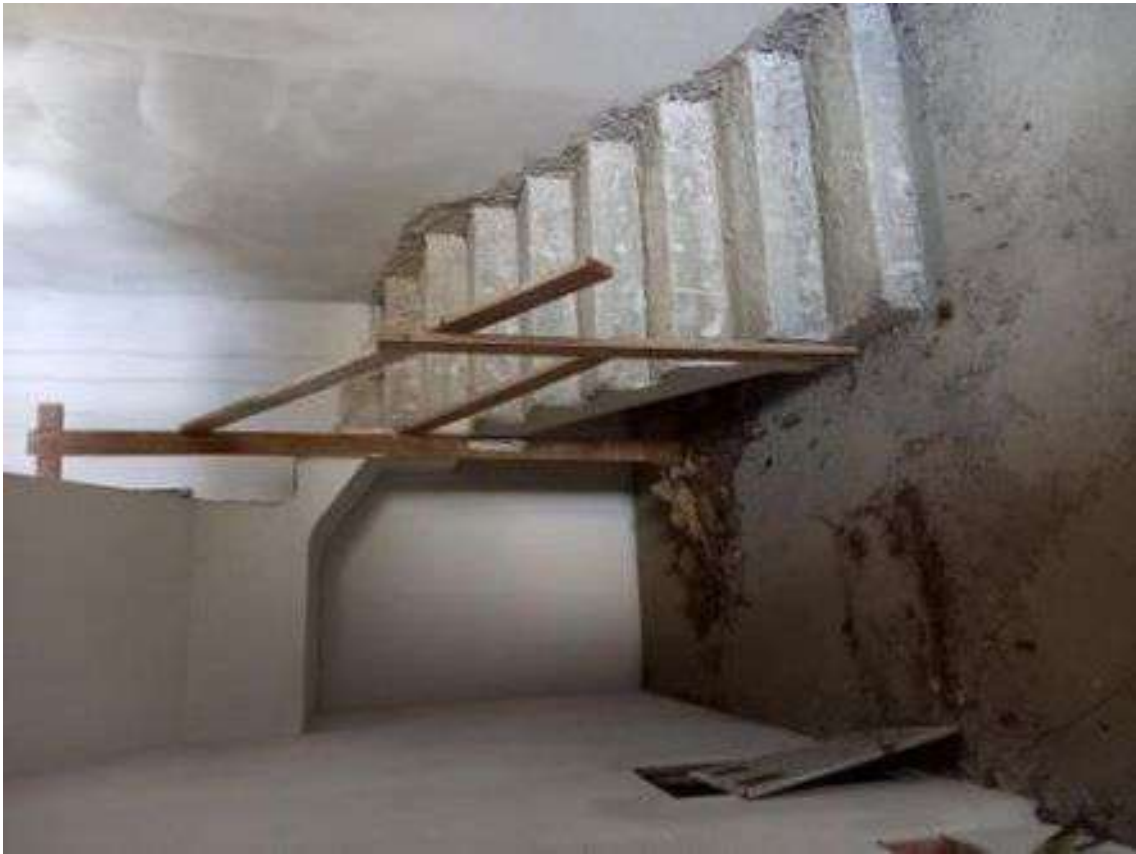
Foto 7 – scala di collegamento piano terra a piano primo
