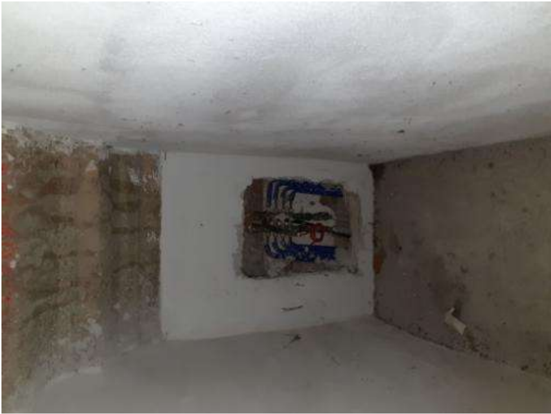
Foto 3- sottoscala piano seminterrato
