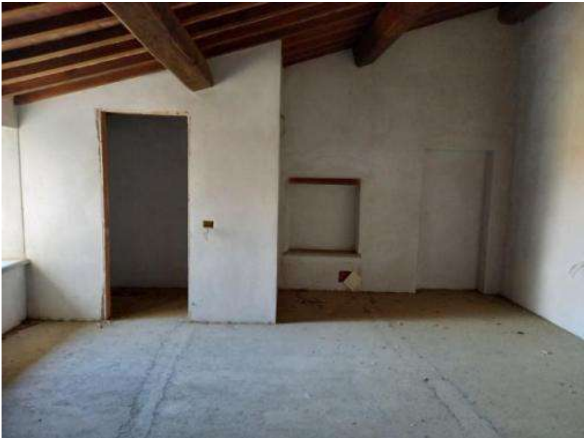
Foto 16 - suddivisione interna piano primo
