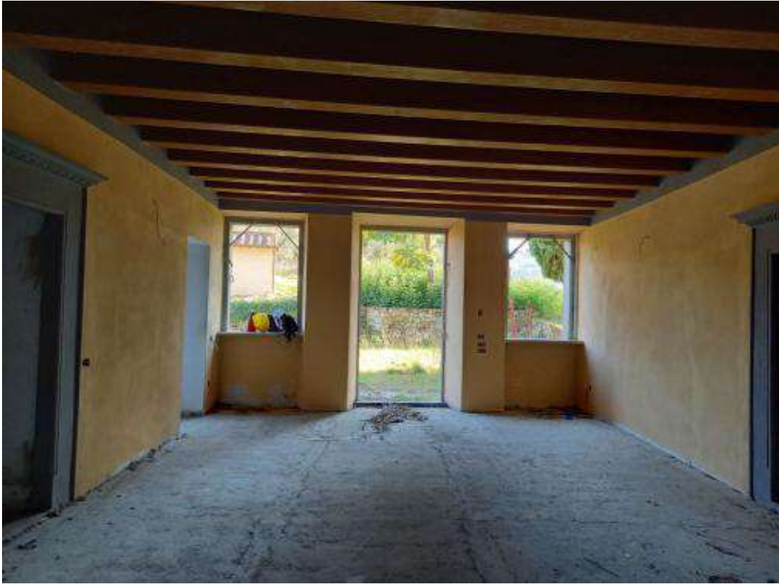
Foto 7 – accesso principale piano terreno
