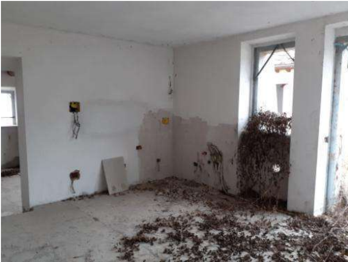
Foto 3 – locale con attacchi cucina piano seminterrato
