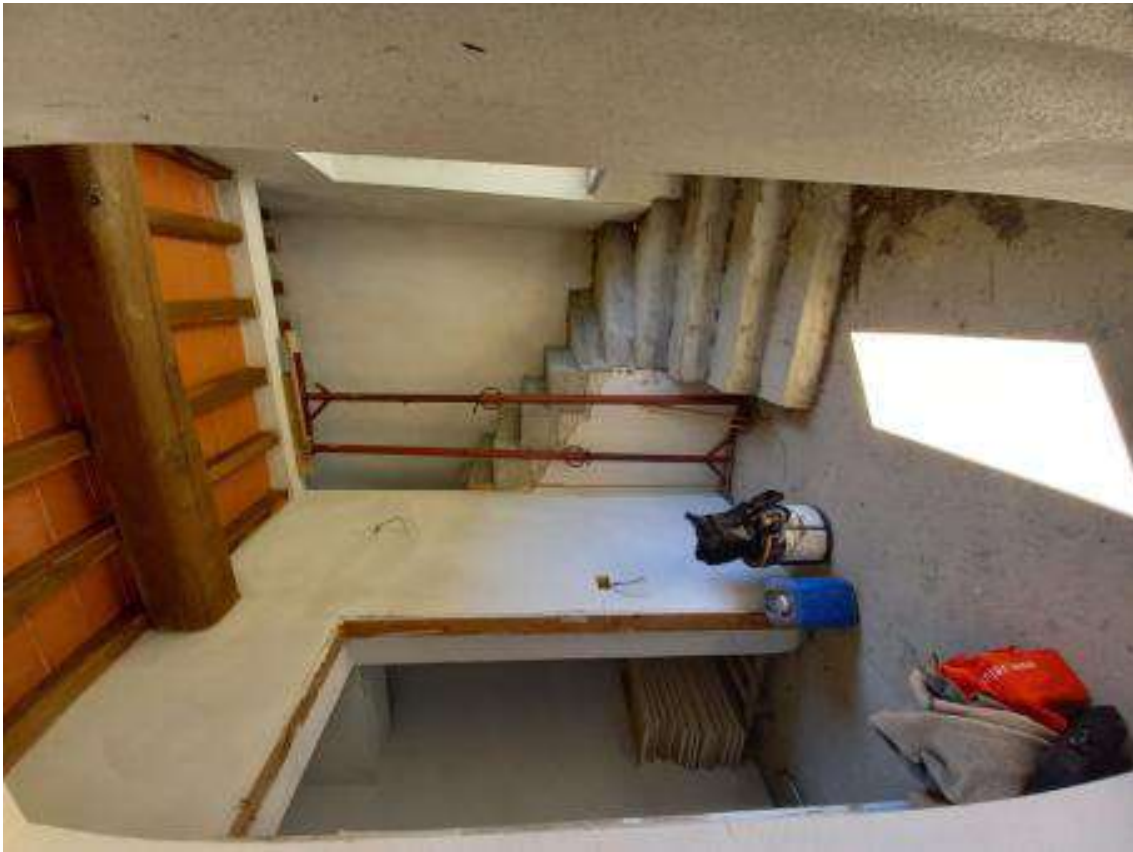
Foto 13 – partenza scala collegamento piano terra con piano primo
