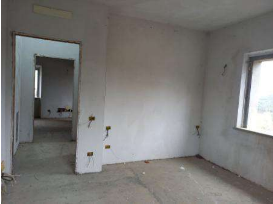
Foto 13 – locale piano primo
