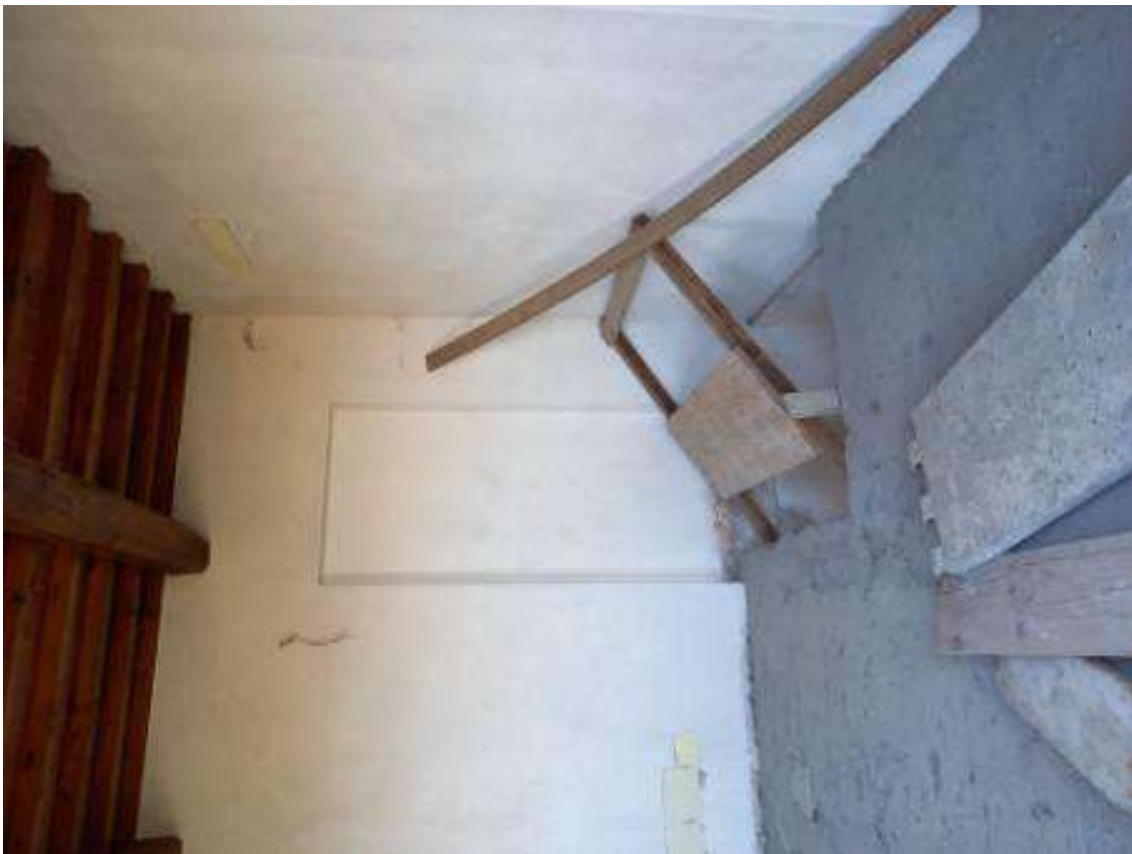
Foto 10 – collegamento verticale solaio interpiano vista dl piano terreno
