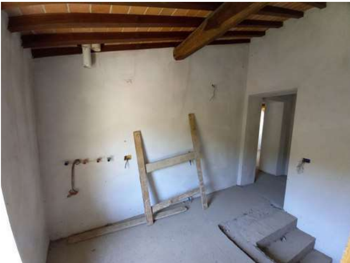
Foto 14 – sbarco scala di collegamento tra piano terra e primo ed individuazione attacchi caldaia
