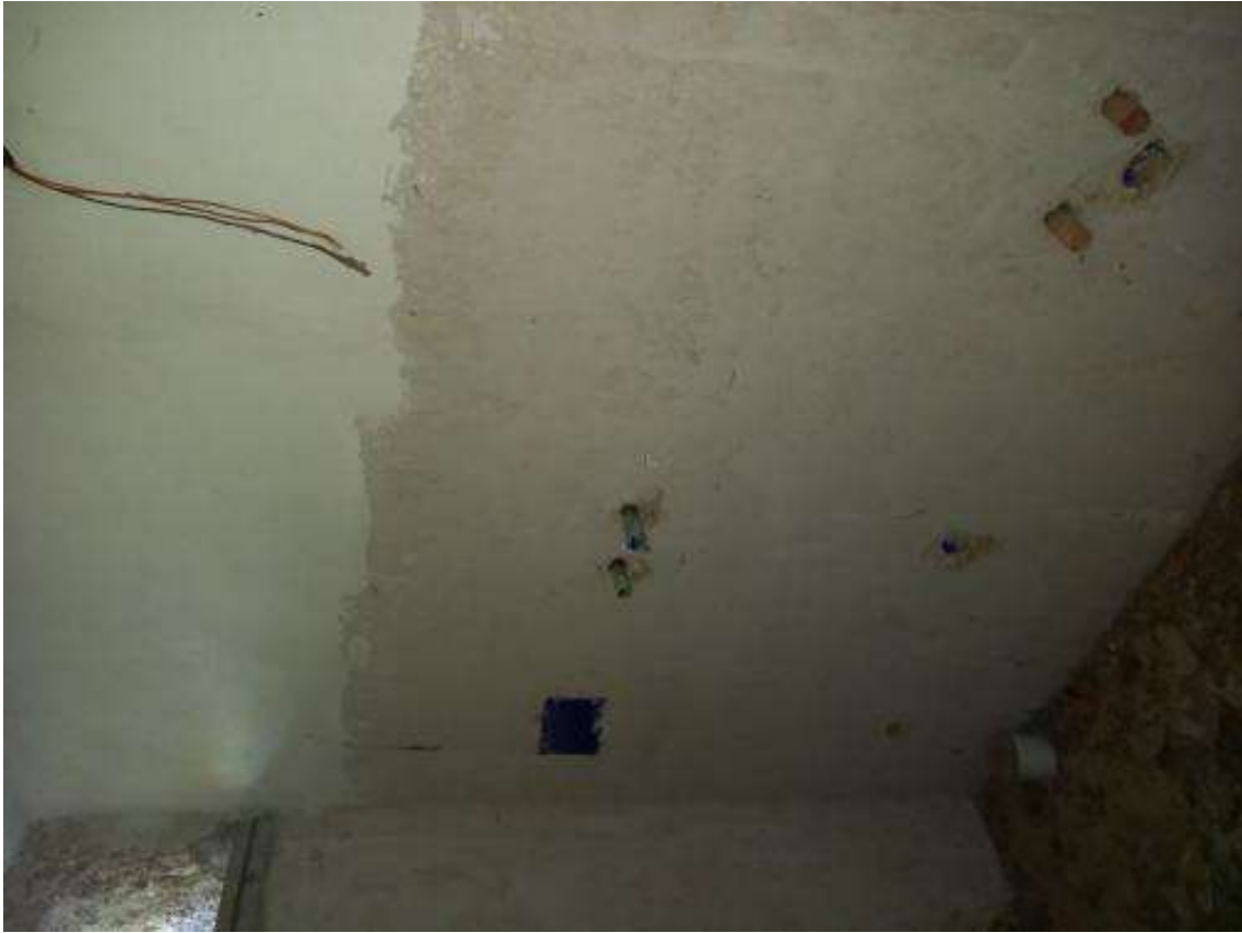
Foto 7 – locale con attacchi wc piano seminterrato
