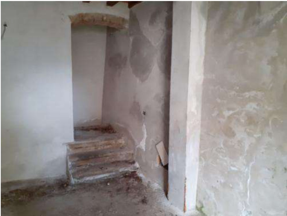
Foto 4 – arrivo scala interna locale piano seminterrato
