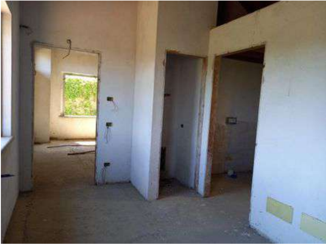
Foto 9 – locali piano primo con individuazione posizionamento impianti
