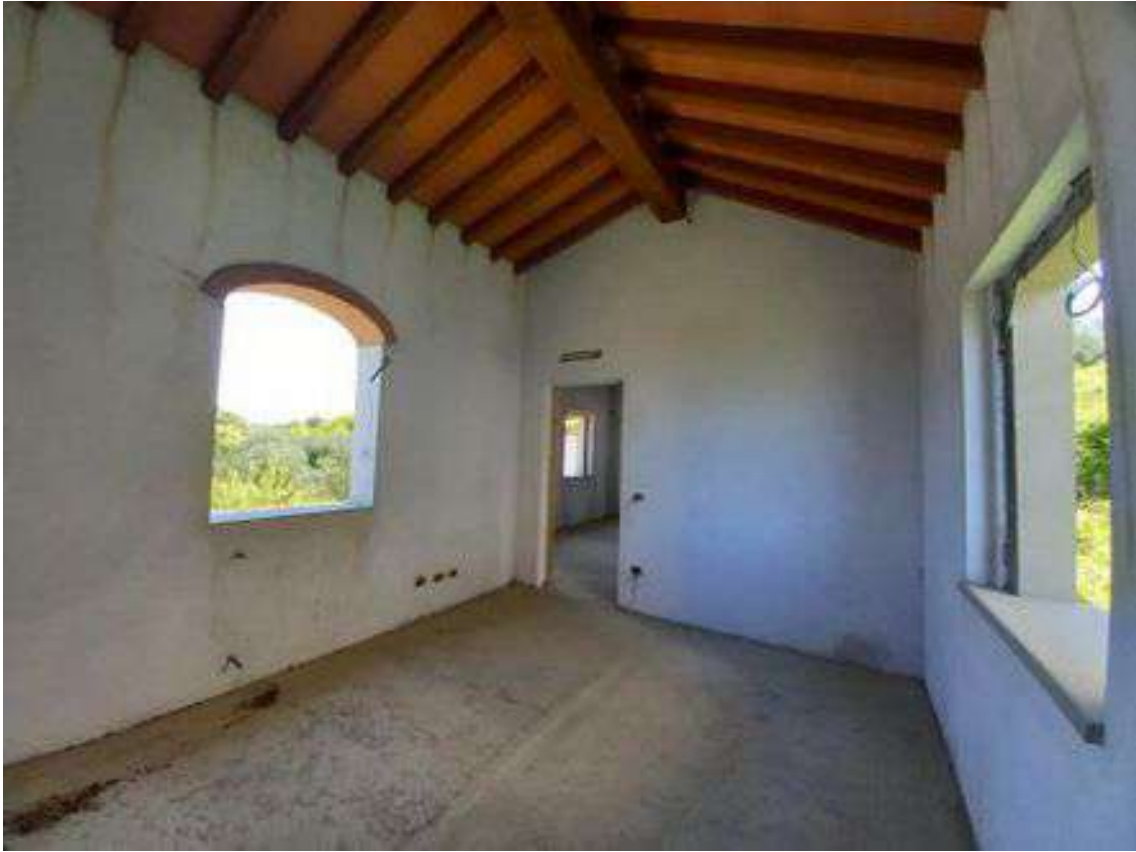
Foto 13 – locale piano primo
