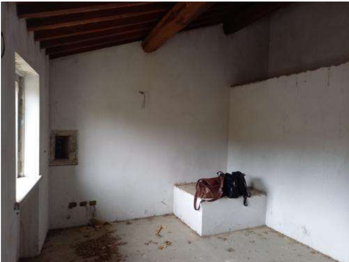
Foto 12 – locale piano primo
