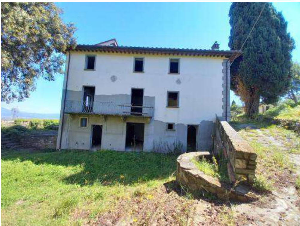
Foto 2 – Prospetto laterale sinistro, accessi piano seminterrato unità n. 1
