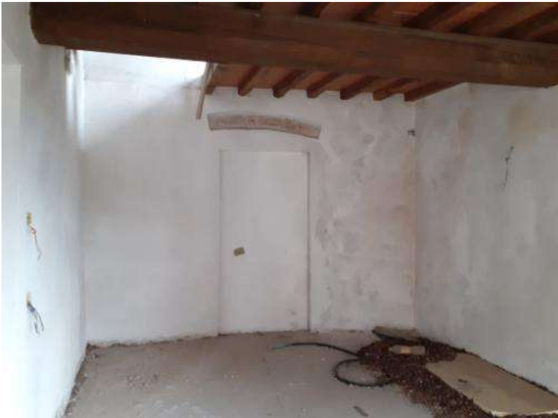
Foto 2 – individuazione collegamento verticale solaio interpiano
