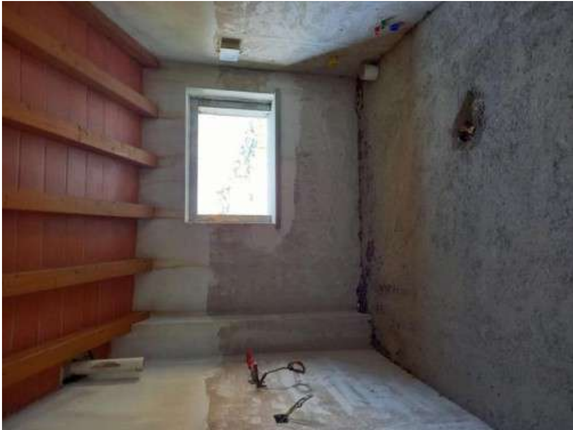
Foto 19 – apertura a tetto locale piano primo
