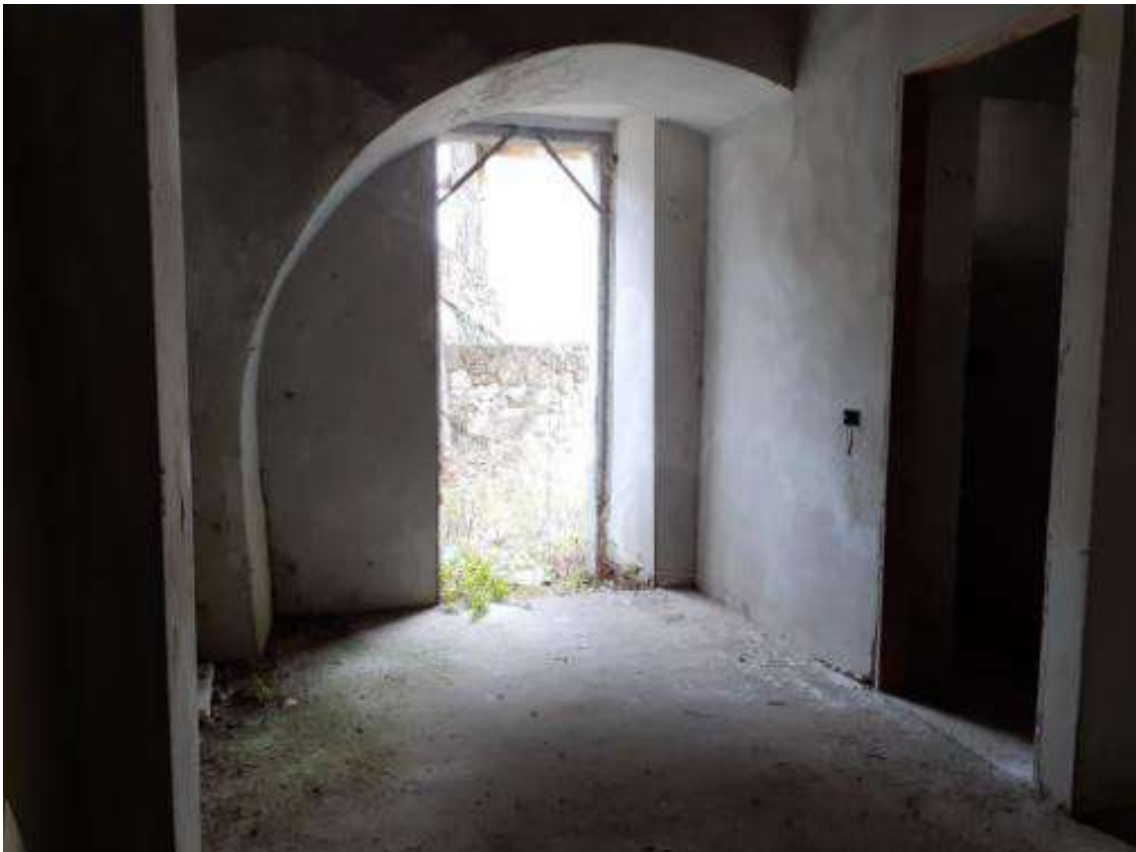
Foto 6 - accesso locale piano seminterrato
