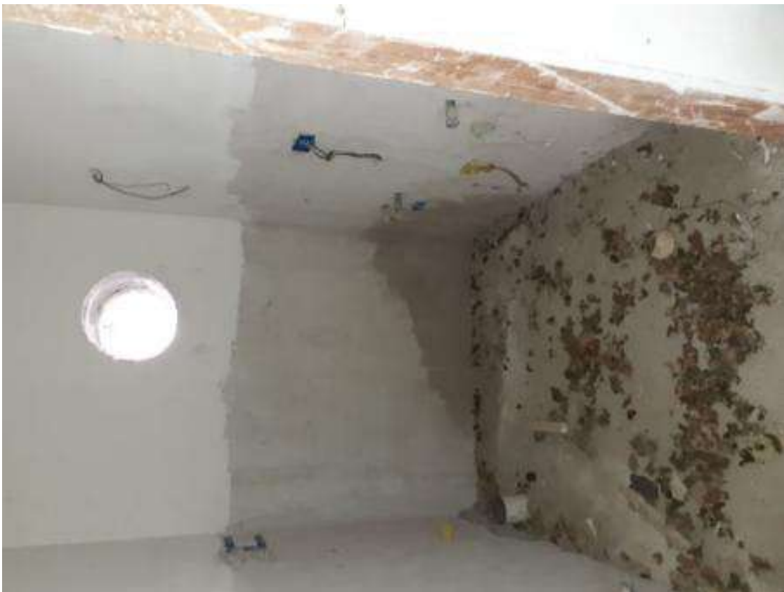
Foto 4 – locale con attacchi wc piano seminterrato
