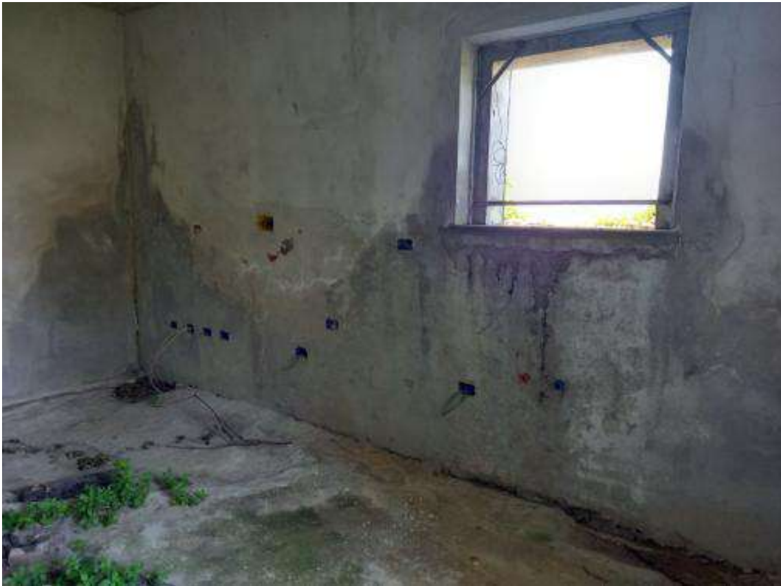
Foto 2 – locale con attacchi cucina piano seminterrato
