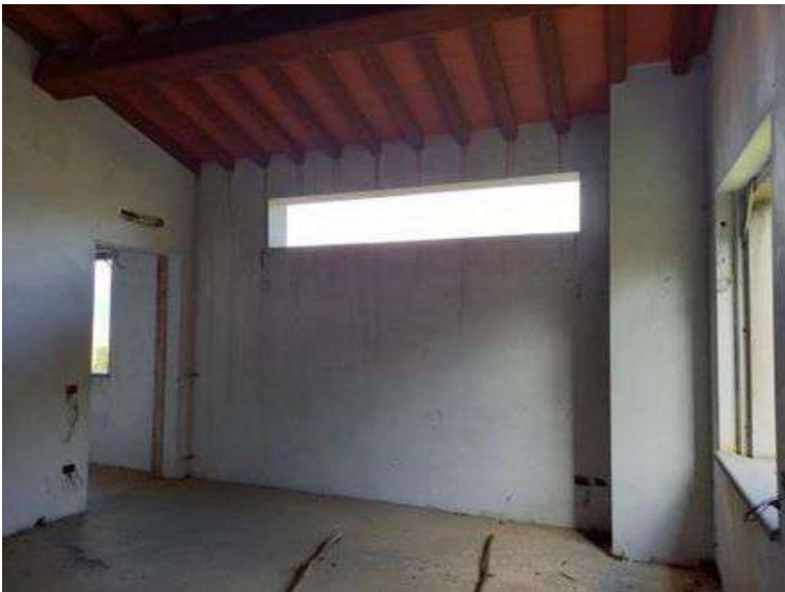
Foto 12 - Locale piano primo
