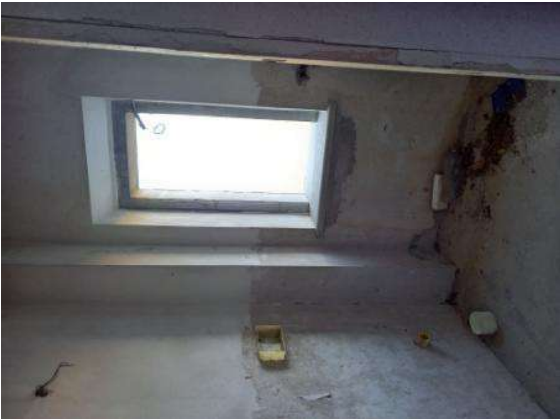
Foto 10 – locale con attacchi wc piano terra
