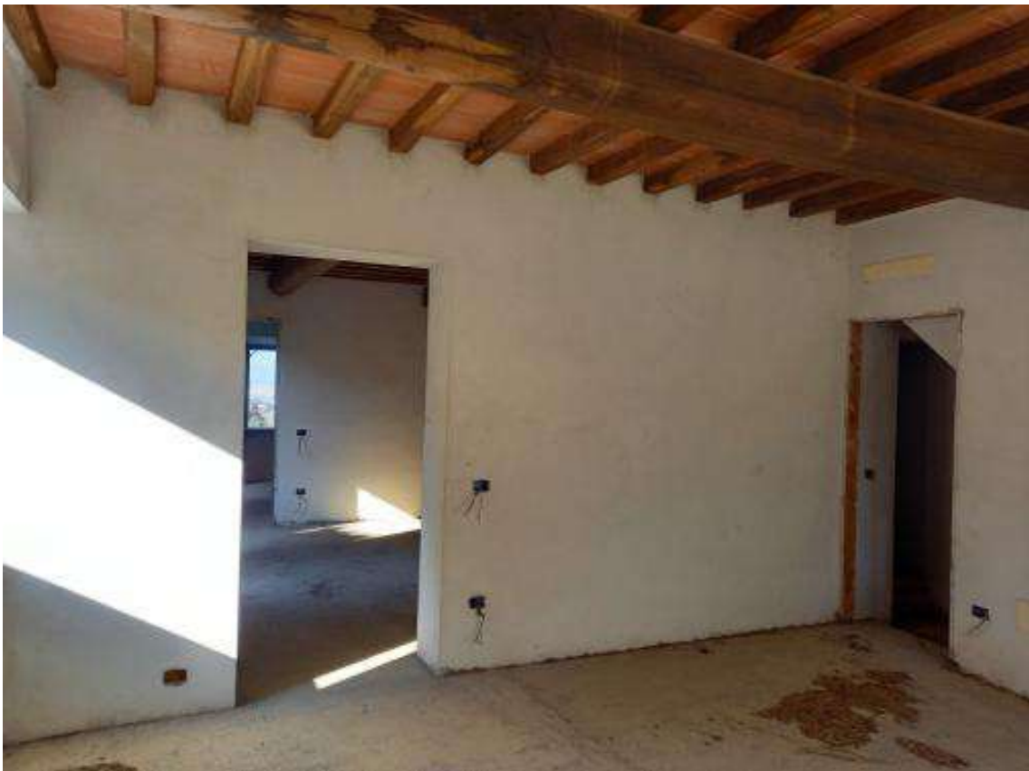
Foto 8 – locali interni piano terra
