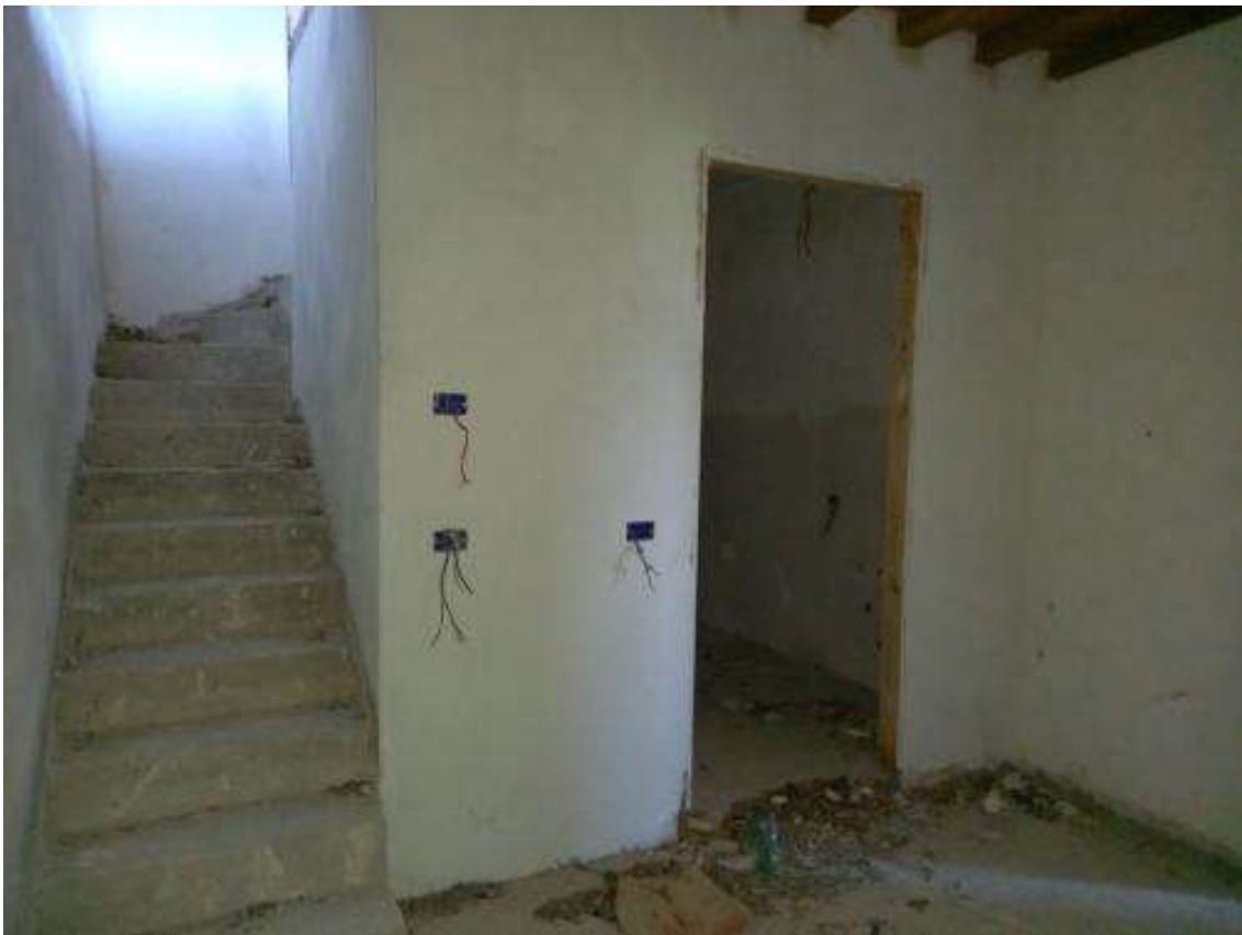
Foto 4- partenza scala interna dal piano seminterrato di collegamento al piano terra
