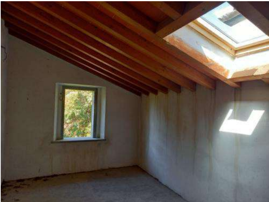
Foto 18 – locale piano primo
