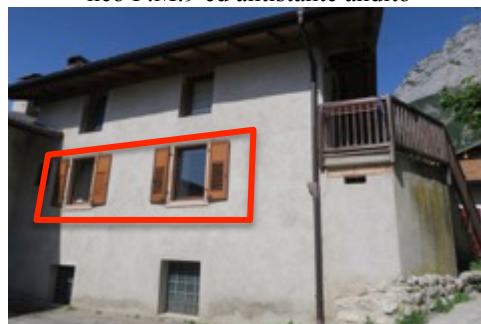
Fronte est P.ed. 179 P.M. 1 In evidenza le aperture dell'unità di piano terra neo P.M. 9
