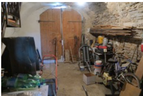
Deposito in comune con la P.M. 2
