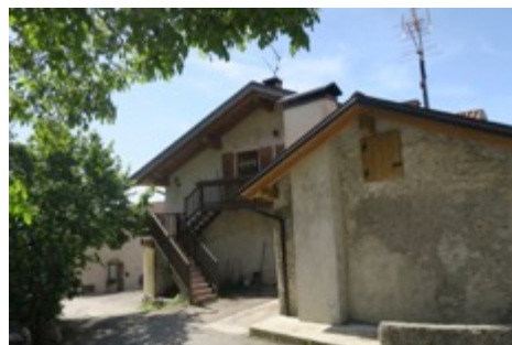
Scala esterna in legno di accesso alla P.M. 1 di primo piano
