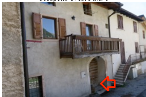
Accesso al locale deposito in comune con la P.M. 2 di piano seminterrato
