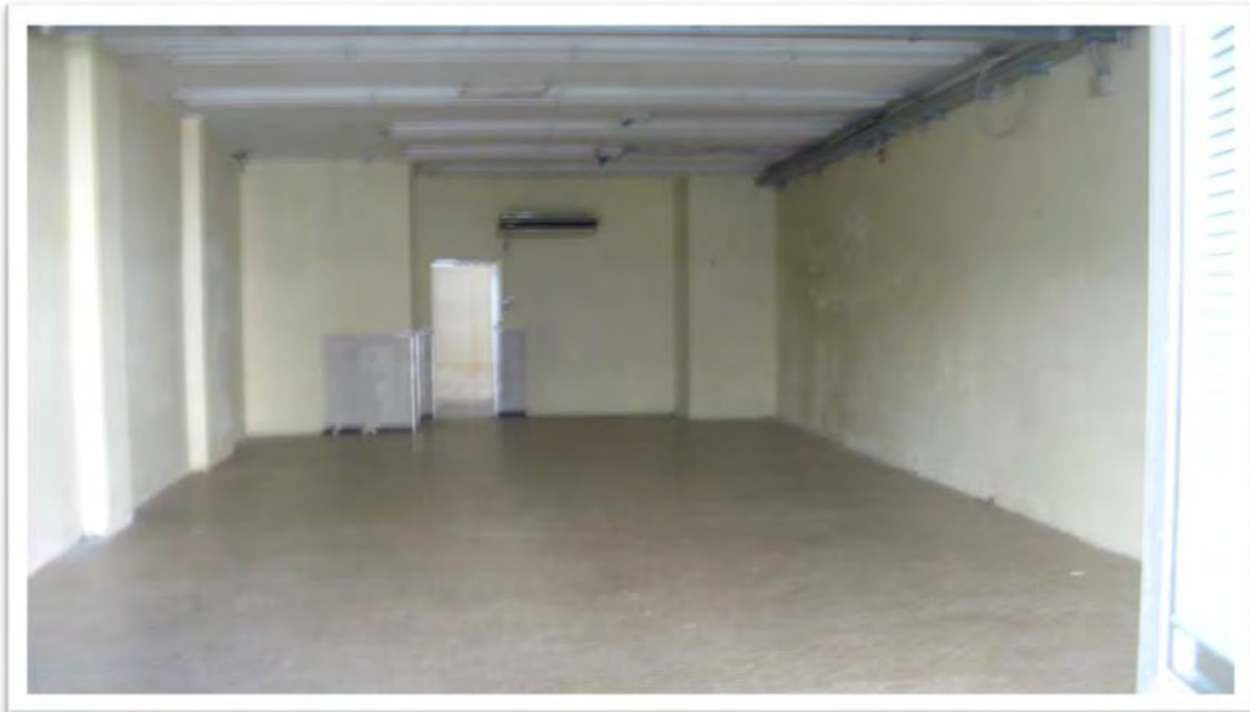
FOTO N. 9 FOGLIO DI MAPPA N. 48 PARTICELLA 46 SUBALTERNO 500 Comune di Fucecchio PIAZZA DONNINI Ponte a Cappiano
