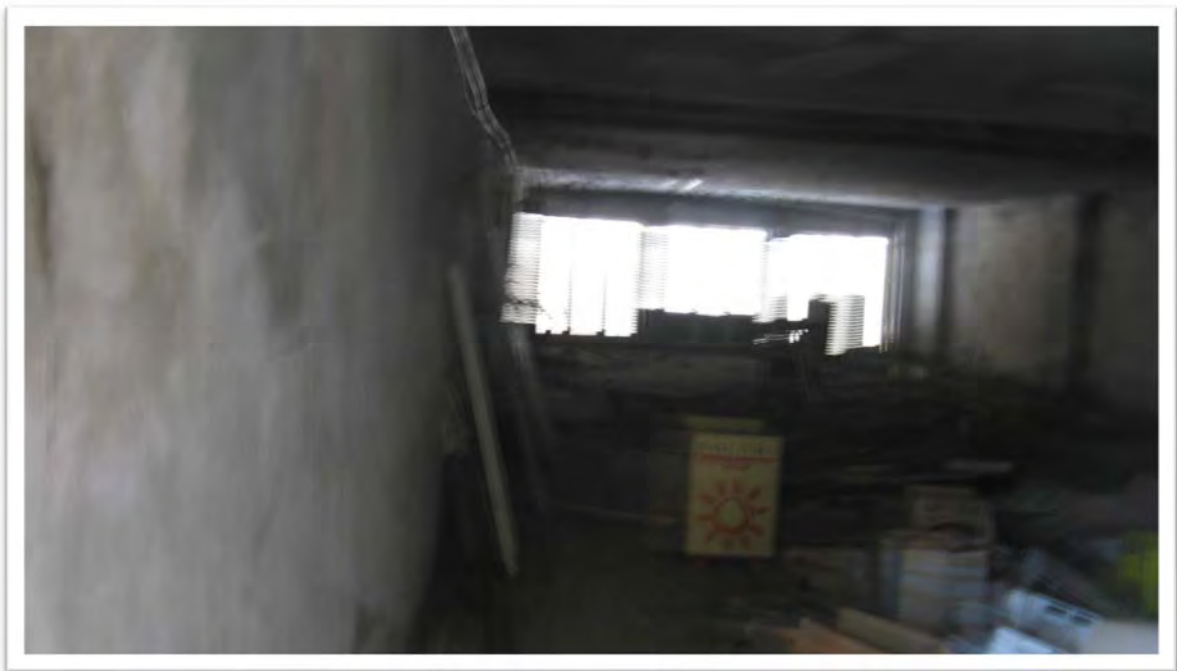
FOTO N. 1 FOGLIO DI MAPPA N. 48 PARTICELLA 46 SUBALTERNO 500 Comune di Fucecchio PIAZZA DONNINI 3 Ponte a Cappiano
