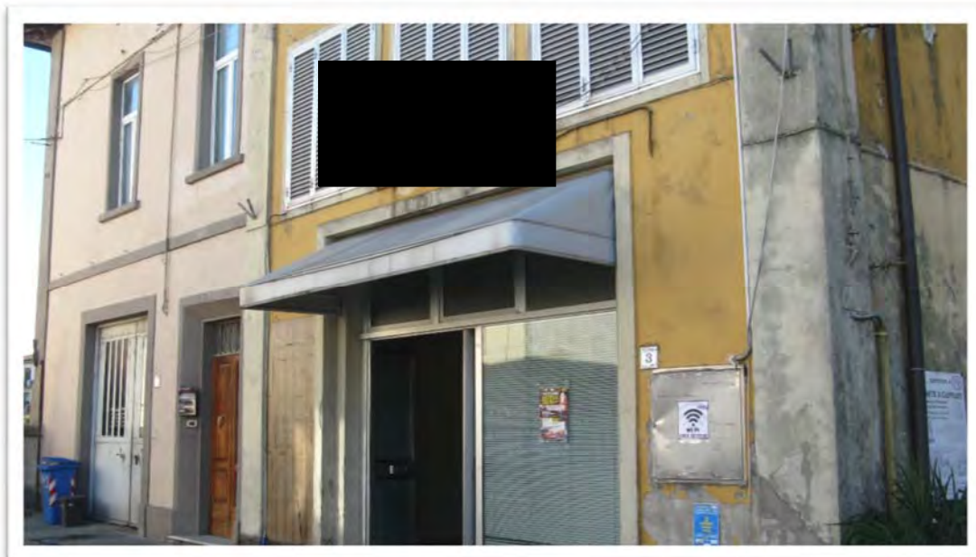
FOTO N. 12 FOGLIO DI MAPPA N. 48 PARTICELLA 46 SUBALTERNO 500 Comune di Fucecchio PIAZZA DONNINI Ponte a Cappiano
