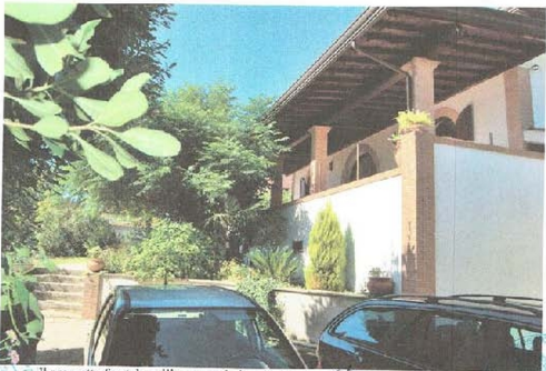
il prospetto frontale, e l'ingresso al piano rialzato
