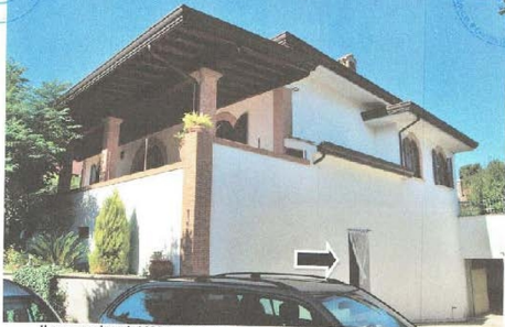
Il prospetto laterale NORD-EST, e l'accesso pedonale al piano seminterrato ed al garage
