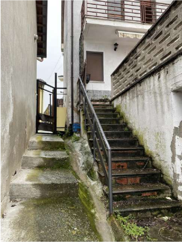
SCALA DI ACCESSO DAL TERRENO DI PERTINENZA AL TERRAZZO
