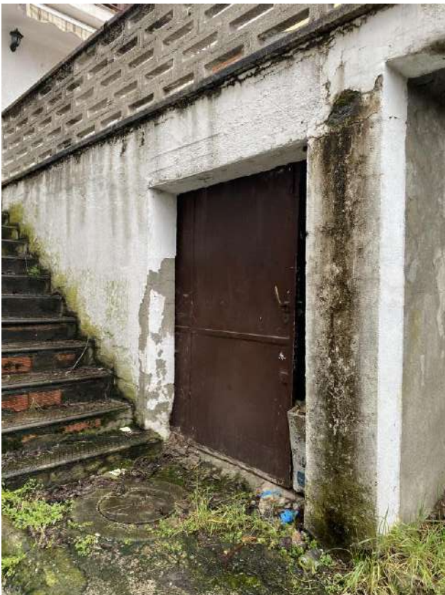
PORTA LOCALE DEPOSITO
