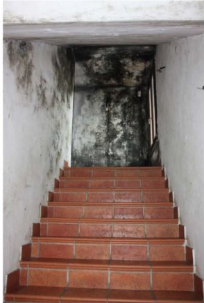
FOTO N. 15: Particolare scala d'accesso al primo piano
