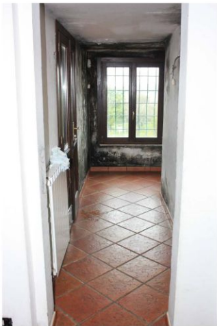
FOTO da N. 16 a N. 20 : Particolari interni abitazione (piano primo)
