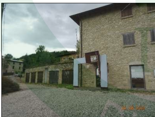
Foto 34 – Area fronte strada
