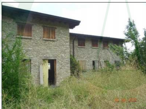
Foto 6 – Prospetto sud accesso
