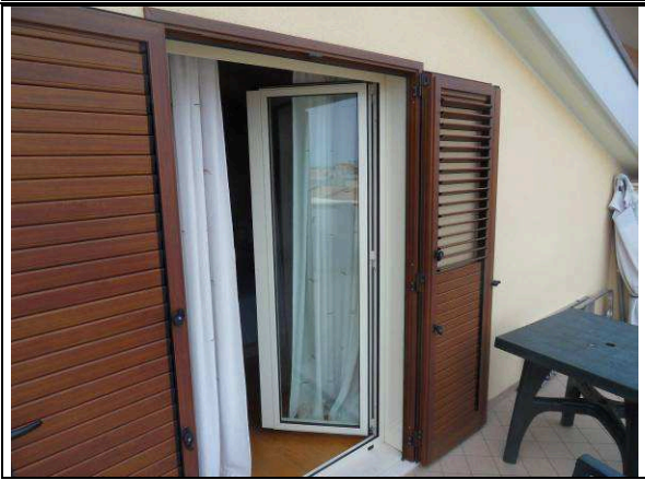
Foto n° 22 – Vista del balcone al piano sottotetto
