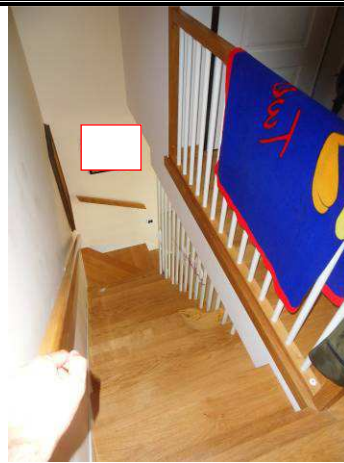
Foto n° 16 – Vista della scala interna
