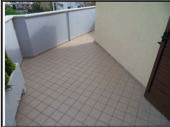
Foto n° 21 – Vista del balcone al piano sottotetto
