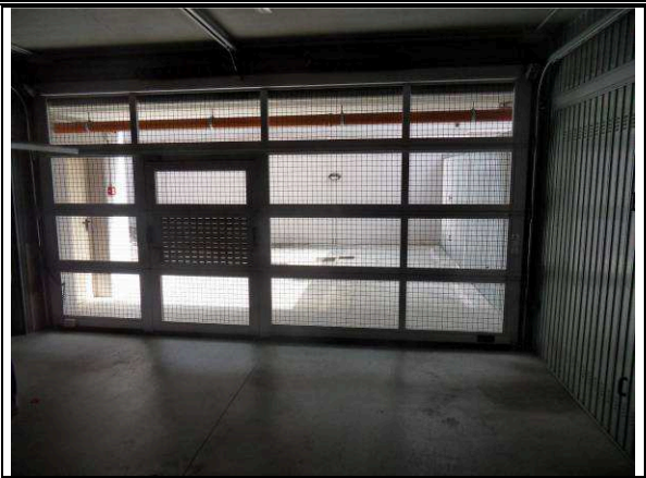
Foto n° 26 – Vista dell'area di manovra - b.c.n.c. (piano interrato)
