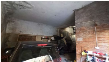
FOTO 26 – DEPOSITO; VISTA INTERNA
