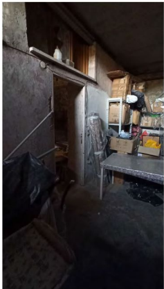
FOTO 32 – LOCALE CALDAIA: VISTA INTERNA CON PORTA VERSO DEPOSITO
