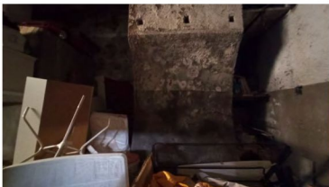
FOTO 35 – DEPOSITO: DETTAGLIO MURATURE
