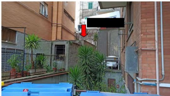
FOTO 38 – VISTA ESTERNA: DISLOCAZIONE DEL LOCALE CALDAIA
