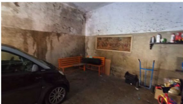
FOTO 25 – DEPOSITO; VISTA INTERNA
