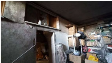
FOTO 34 – LOCALE CALDAIA: VISTA INTERNA
