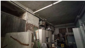
FOTO 36 – DEPOSITO: DETTAGLIO MURATURE E CISTERNE
