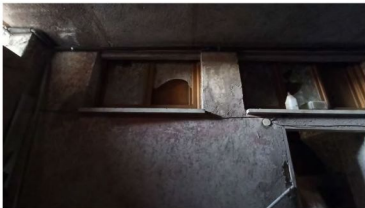
FOTO 31 – LOCALE CALDAIA: VISTA INTERNA
