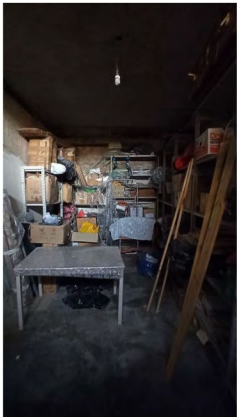
FOTO 33 – LOCALE CALDAIA: VISTA INTERNA
