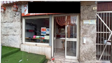
FOTO 7 – VISTA ESTERNA DA VIA COSTA BATOCCHI 10
