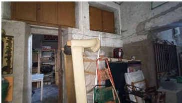
FOTO 30 – DEPOSITO: VISTA INTERNA CON PORTA VERSO LOCALE CALDAIA
