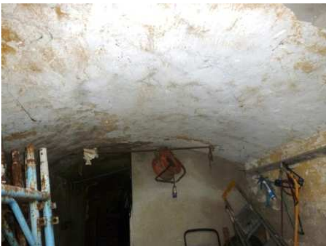
Foto 10. Particolare intradosso solaio cantine
