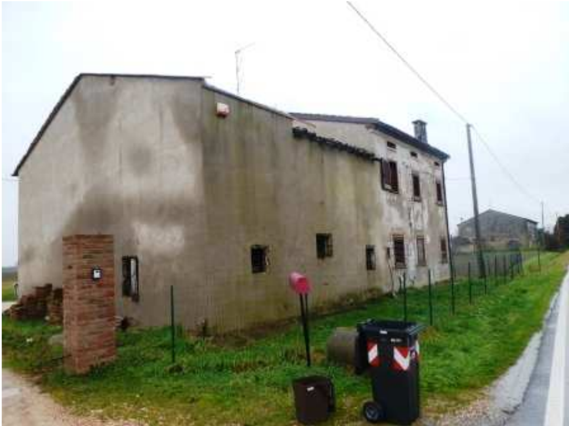
Foto 1 Particolare immobile ove è inserita l'u.i. oggetto di procedura
