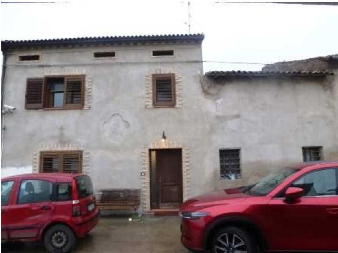
Foto 2. Particolare accesso esterno all'unità
