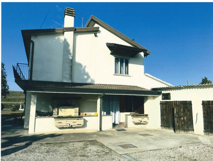
Fabbricato vista Est
