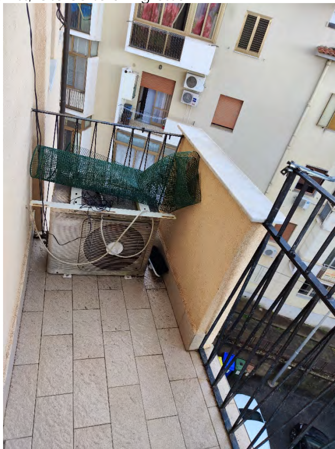
Balcone esposto a Est, lato corte di ingresso
