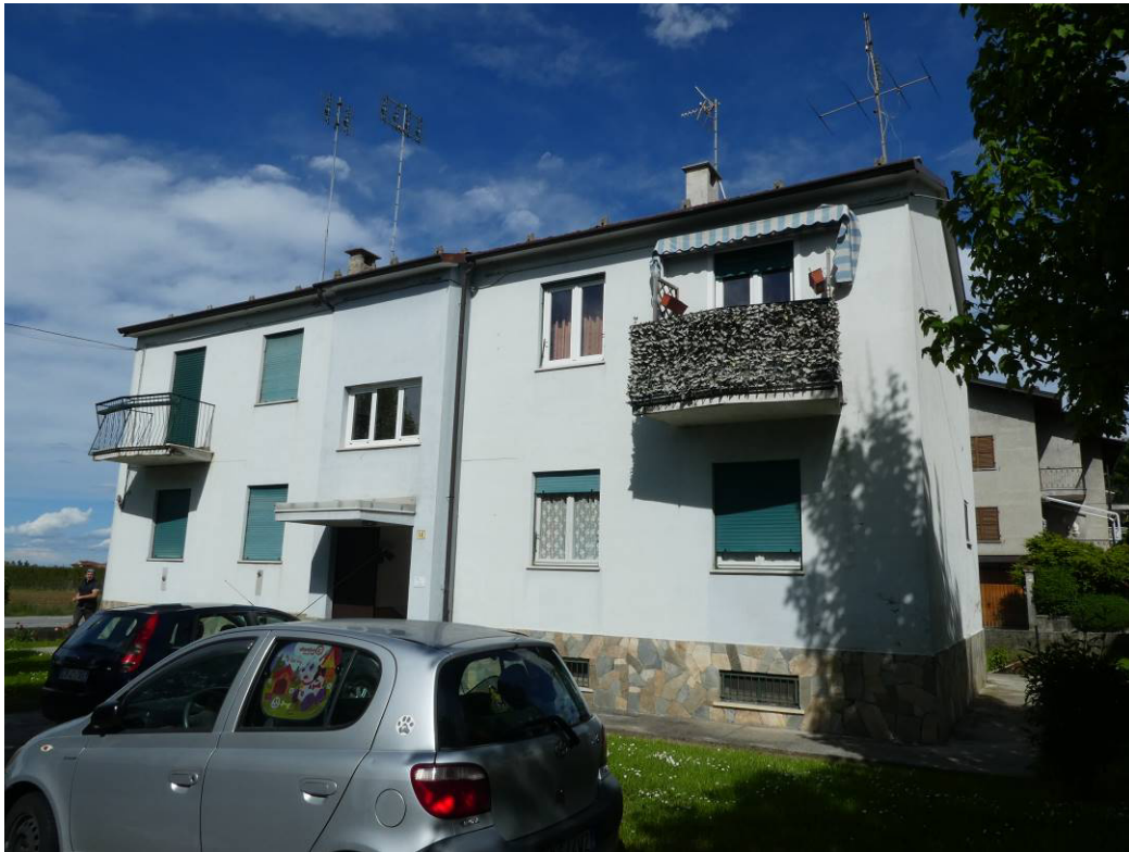
-1- facciata principale (Ovest)
