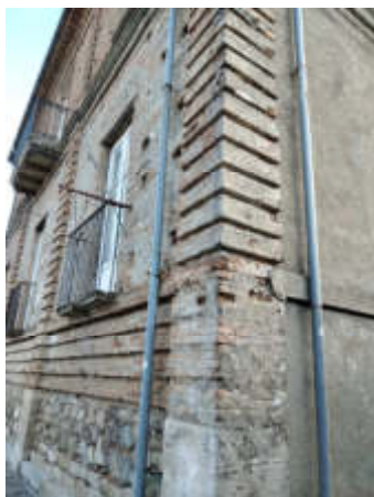
Foto n. 3 – Angolo largo Fontana (balcone immobile)
