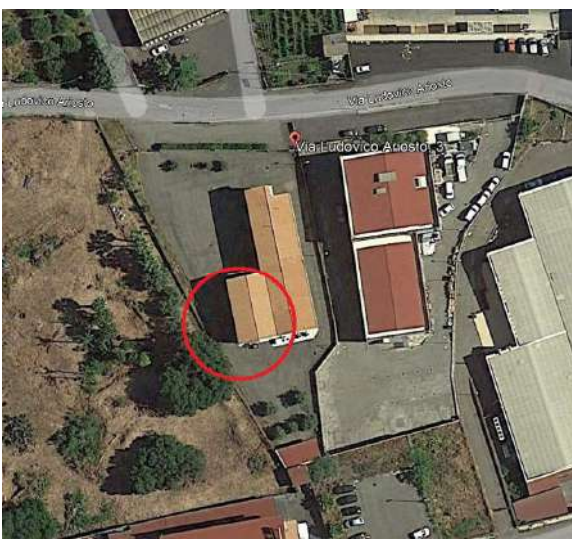
Foto aerea del 06/06/2014- la tettoia lato sud è realizzata, i volumi in aderenza al fabbricato non sono ancora presenti.
