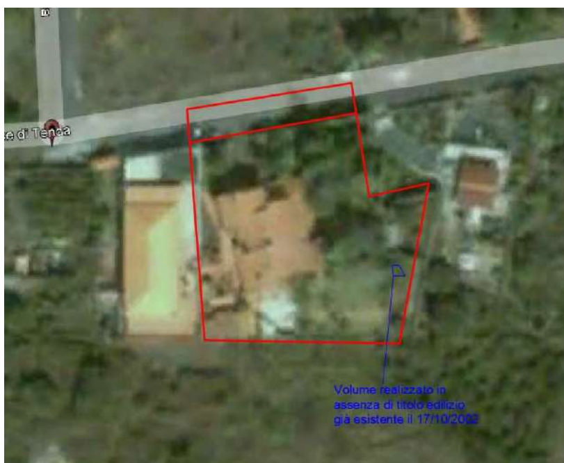
Foto aerea - immagine scattata il 17/10/2002 in cui è visibile solo il volume sul lato est
