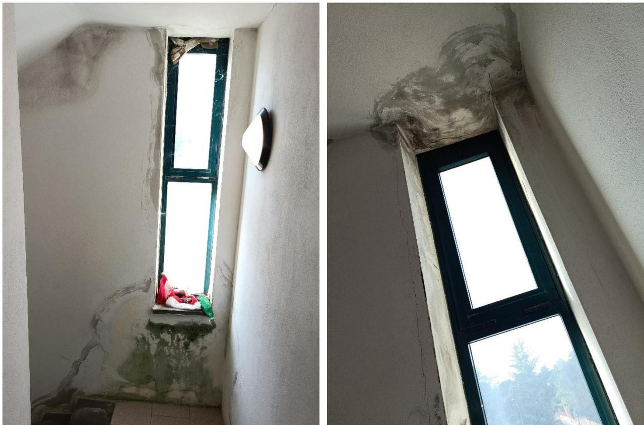
Foto n.06-07 – stato di degrado locali vano scala
