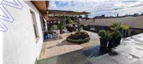
Vista da terrazzo piano primo
