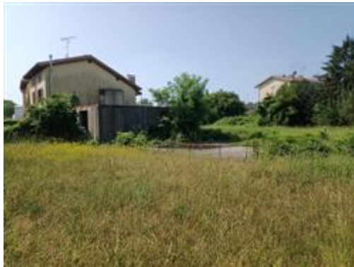
Platea di fondazione e corpo al grezzo
