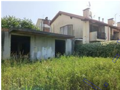
Dettaglio del corpo al grezzo
