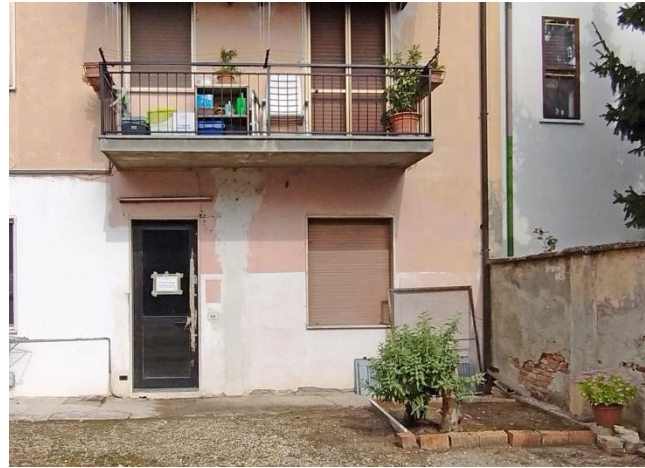
Dettaglio fronte verso il cortile
