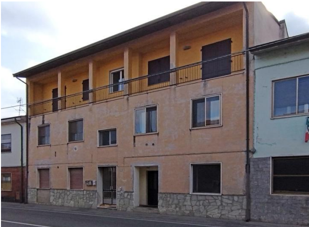
Fronte su Via Villani (ingresso dal cortile interno)
