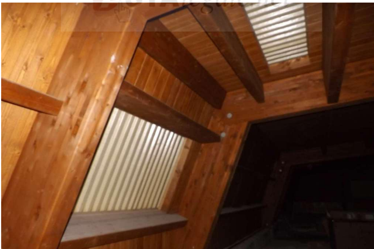
Foto 58 - Appartamenti fg 26 part. 268 sub.70-71
