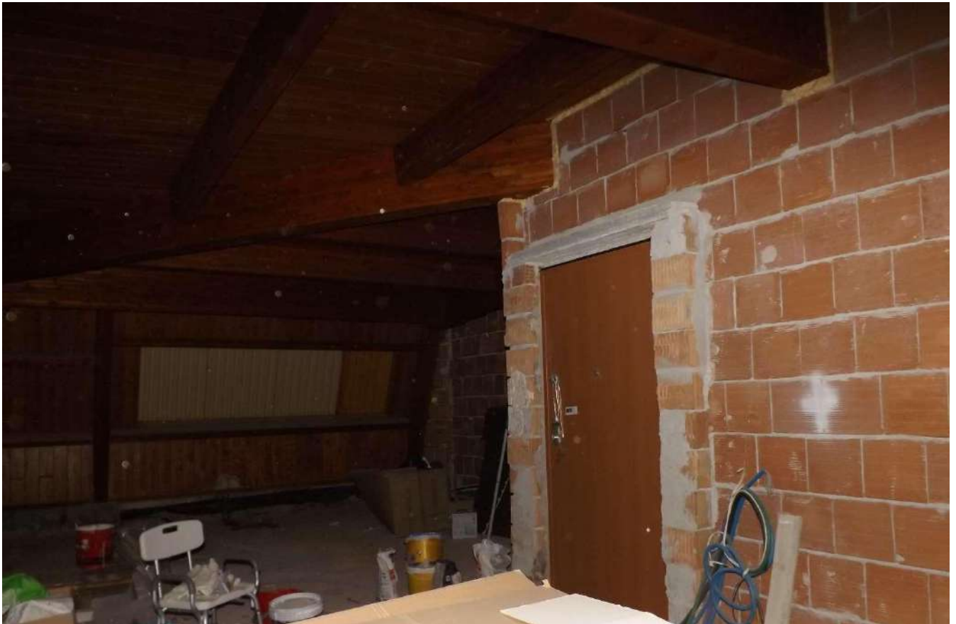
Foto 59 - Appartamenti fg 26 part. 268 sub.70-71
