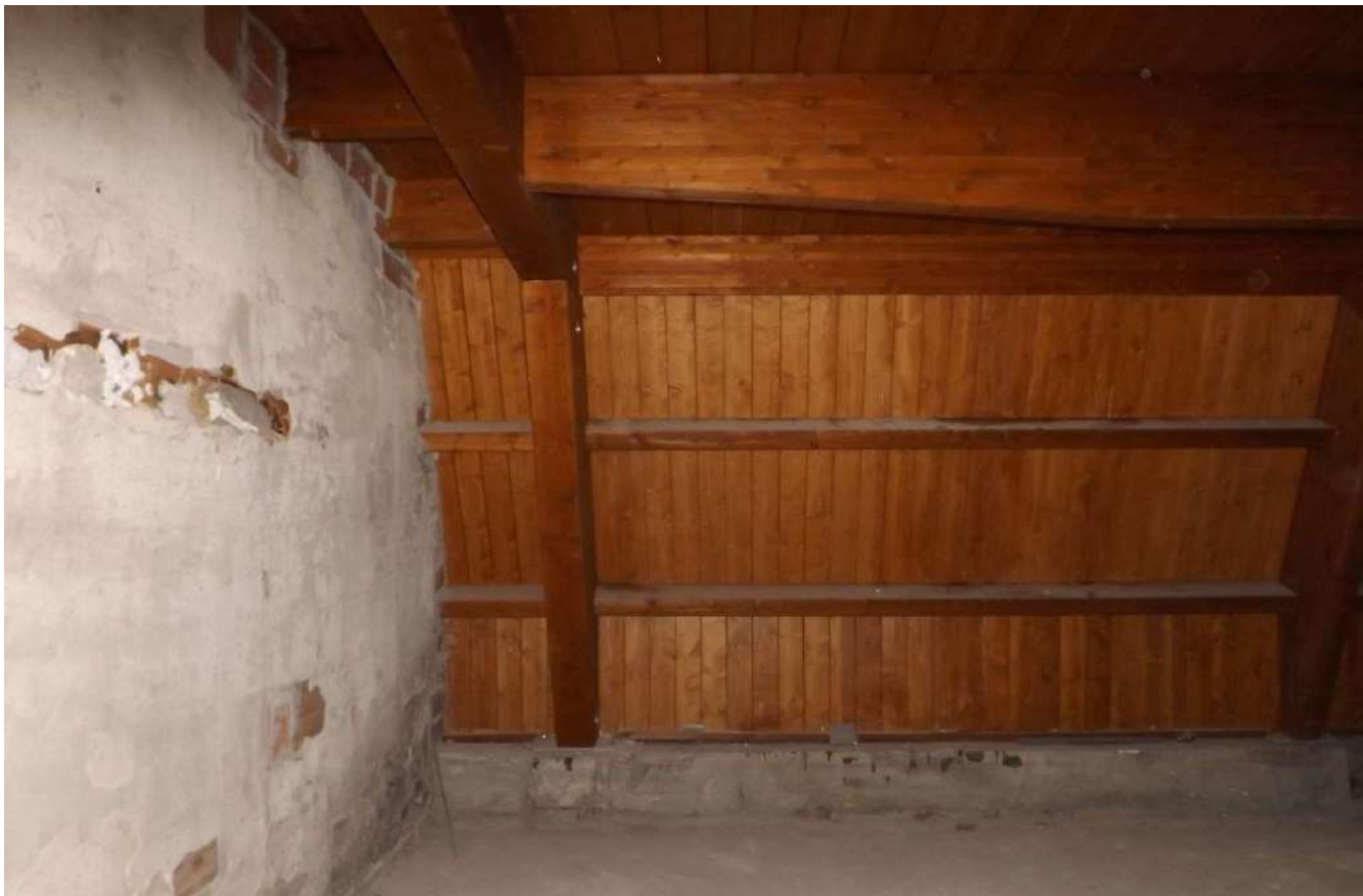
Foto 57 - - Appartamenti fg 26 part. 268 sub.70-711
