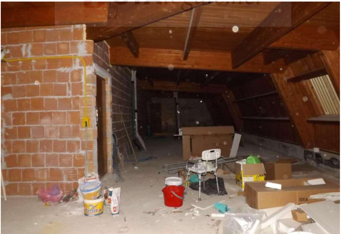
Foto 60 - Appartamenti fg 26 part. 268 sub.70-71
