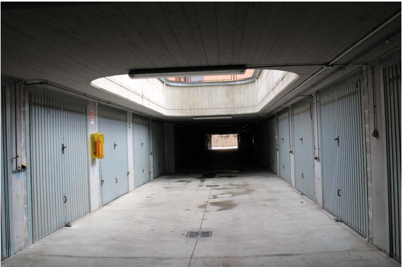
FOTO N° 18: Corsia di manovra box-garage
