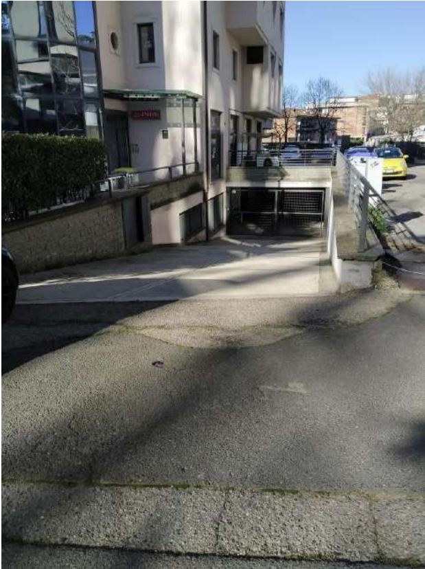
Rampa accesso di fronte e di lato
