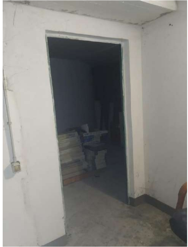
entrata piccolo locale inglobato nel sub 8
