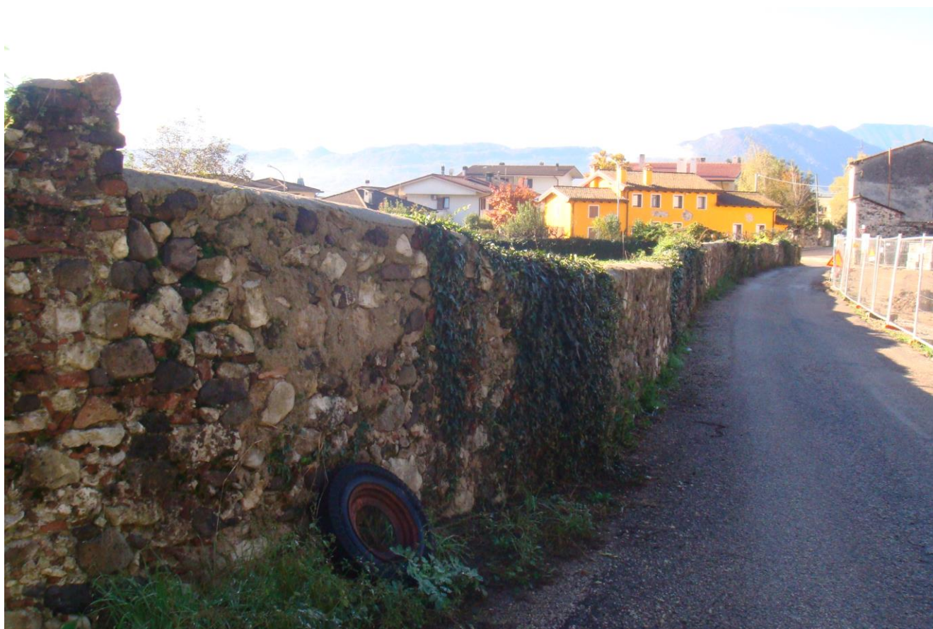
MURO IN SASSO CHE DELIMITA IL MAPPALE DALLA VIA VOLTO
