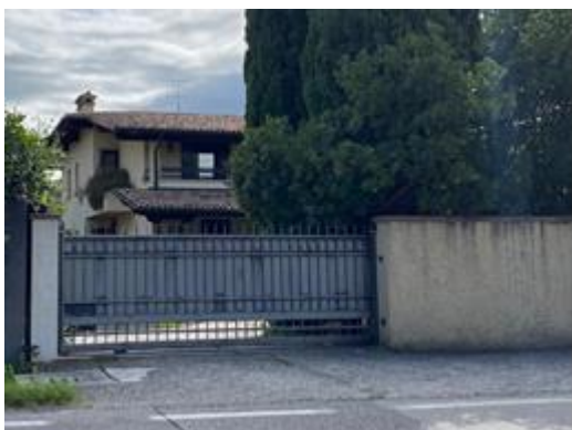
- Veduta generale esterna fabbricato
