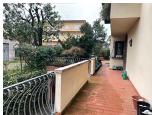
- Veduta generale fabbricato
