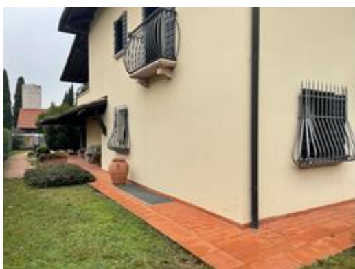
- Veduta generale fabbricato
